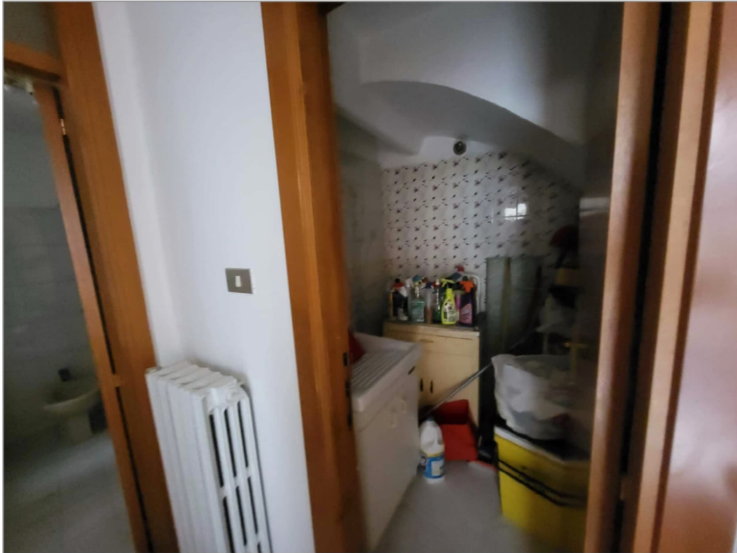
RIPOSTIGLIO PIANO TERRA
