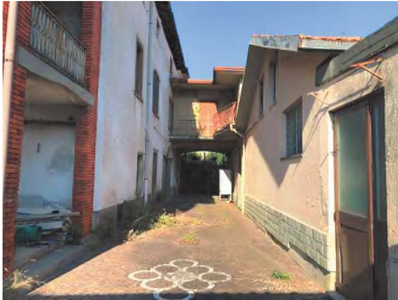
area comune - accesso
