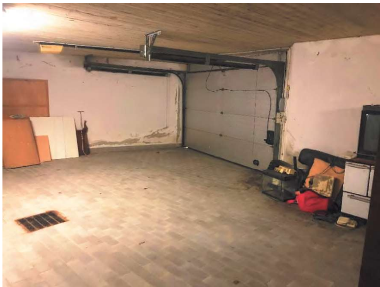
portone accesso interrato
