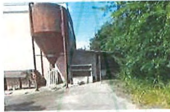
FOTO 13 - vista di lato del manufatto "torreggio" da sinistra e struttura adiacente a destra
