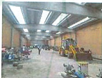
FOTO 13 - vista interna del magazzino
