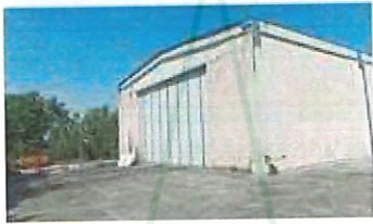
FOTO 11 - fronte Ovest del magazzino
