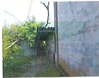
FOTO 14 - vista di lato del manufatto "torreggio" da sinistra e struttura adiacente a destra
