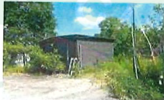
FOTO 8 - vista di uno dei manufatti "integrati" da demolire a sinistra, insieme lo stesso in funzione gruppo
