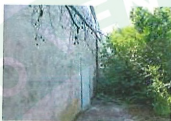
FOTO 11 - esterno del vano del magazzino. Vista Nord
