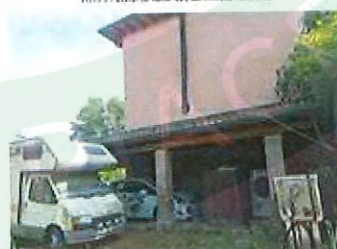
FOTO 6 - Vista laterale dell'immobile residenziale
