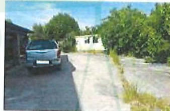
FOTO 10 - vista di uno dei manufatti "integrati" da demolire a sinistra, insieme al parcheggio
