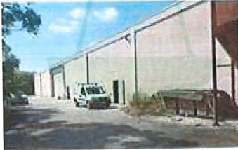
FOTO 12 - fronte Sud del magazzino
