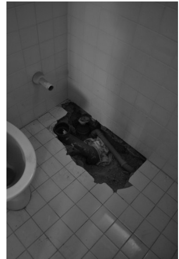
figg. n.18-19-20. Bagno con dettaglio del wc dismesso e rottura massetto e rivestimento
