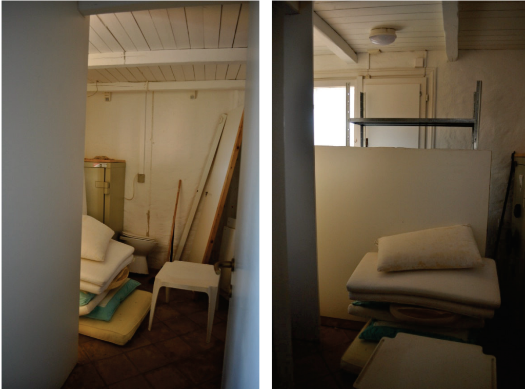
figg.n.21-22. Camera antistante il bagno con parete in multistrato dismessa
