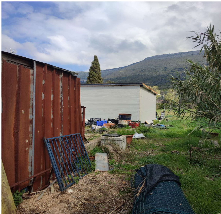
Foto 6 – Lato retrostante l'abitazione – Manufatto per ricovero auto, in metallo e pannellature tipo isopan
