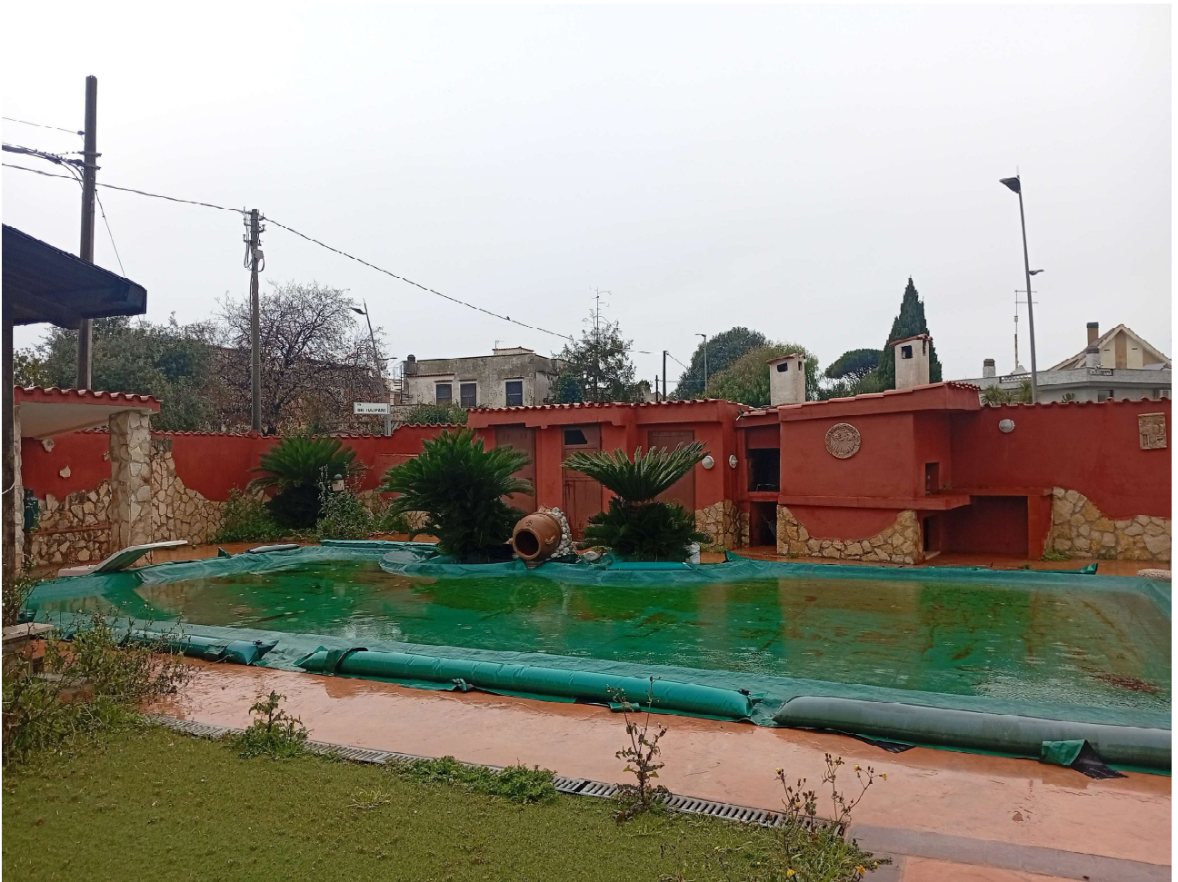
Veduta laterale giardino, piscina interrata e vani tecnici realizzati su muro perimetrale
