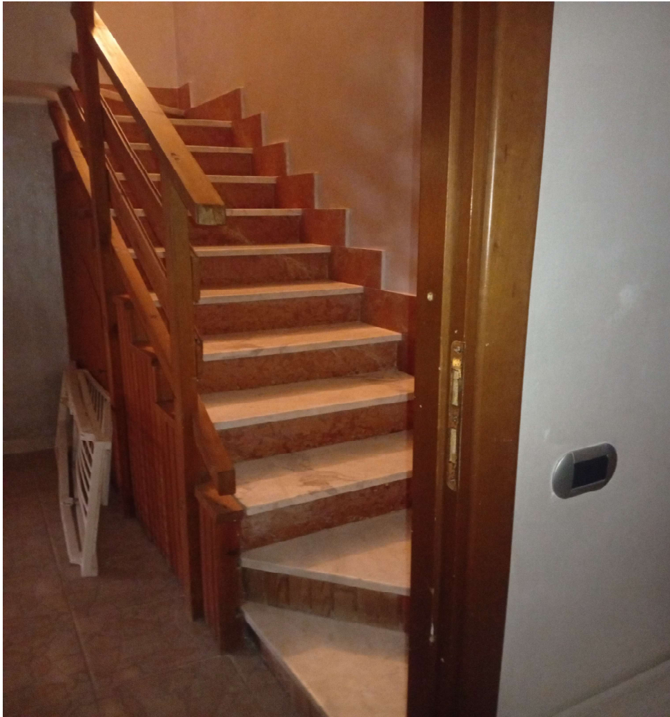
Scala di collegamento tra il piano terra (rialzato) ed il piano seminterrato
