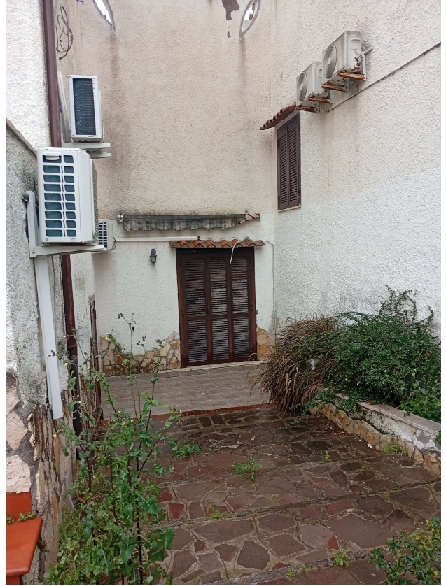
Uscita dalla camera al piano seminterrato
