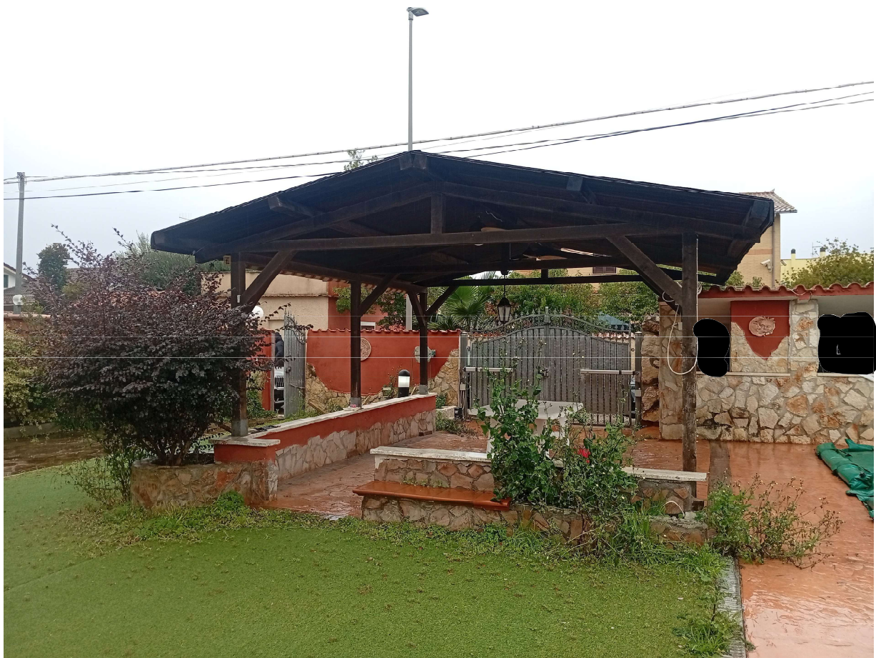
Struttura con pilastri in legno e tettoia ardesiata per copertura posto auto
