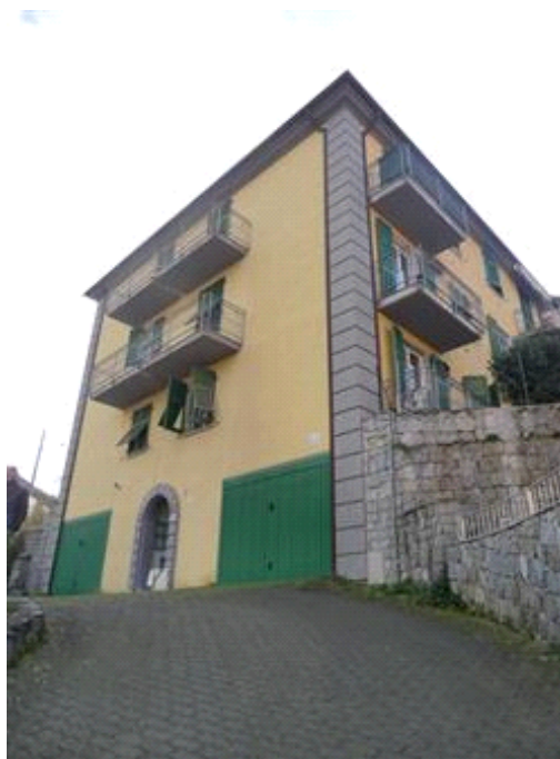
Condominio di via Ugo Botti n. 49/A - La Spezia
