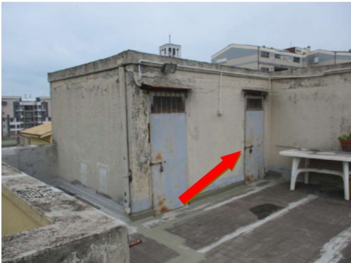
14 – esterno al piano 3° - sub.9 (terrazzo)
