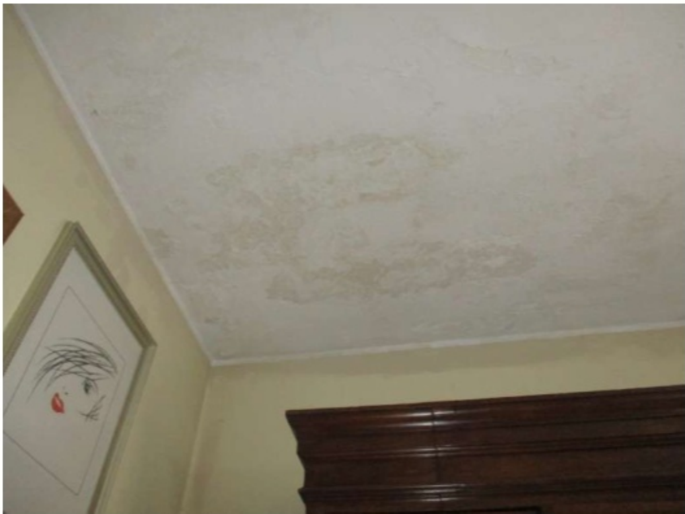
12 – interno al piano 2° - sub.9
