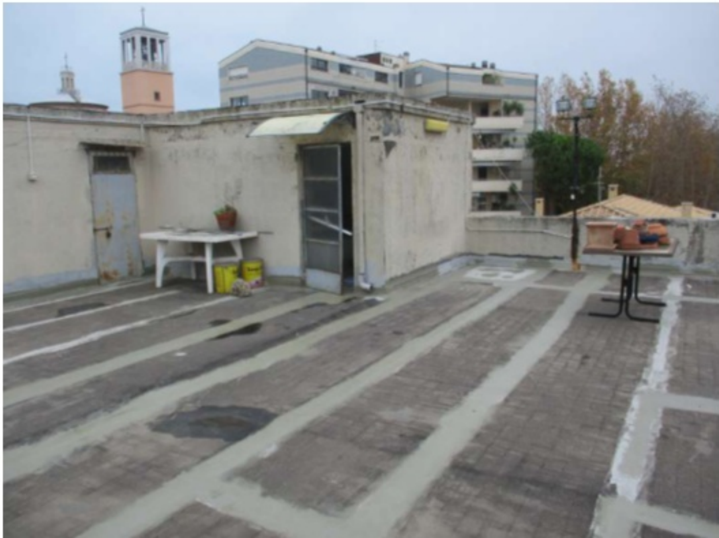
13 – esterno al piano 3° - sub.9 (terrazzo)
