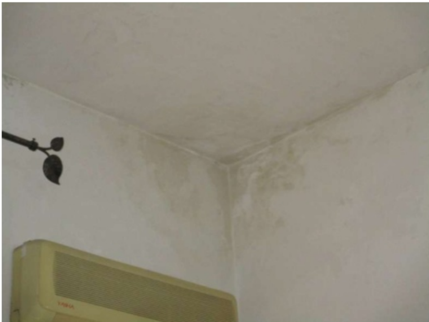
10 – interno al piano 2° - sub.9
