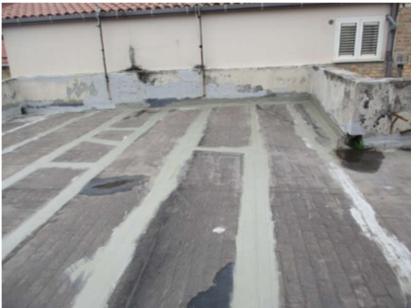
15 – esterno al piano 3° - sub.9 (terrazzo)
