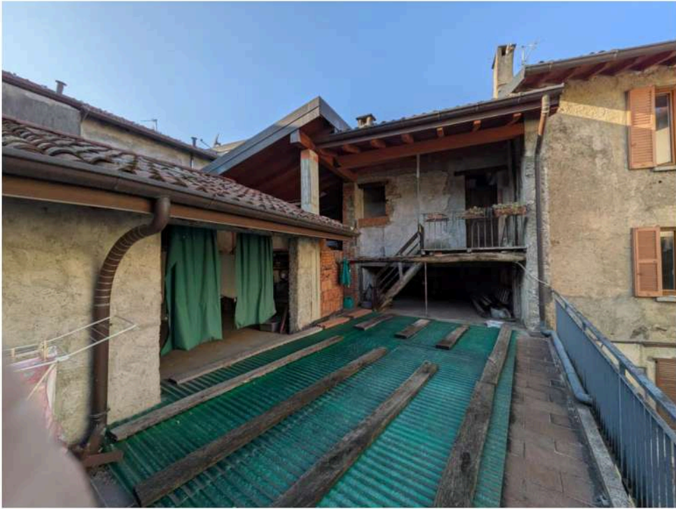
Foto 19 – terrazza interna Lotto 2
