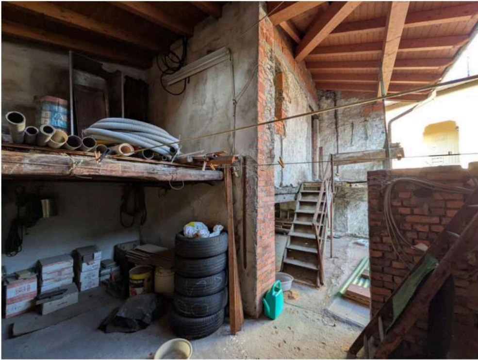
Foto 21 – ambienti in copertura al rustico Lotto 2
