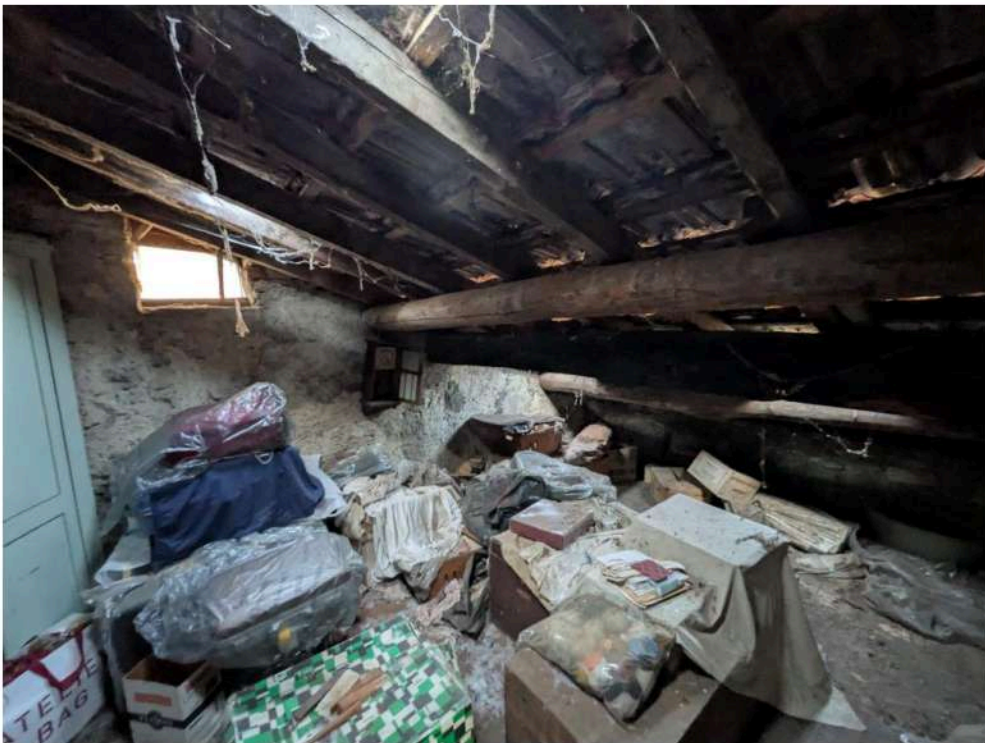
Foto 18 – sottotetto a sgombero Lotto 2
