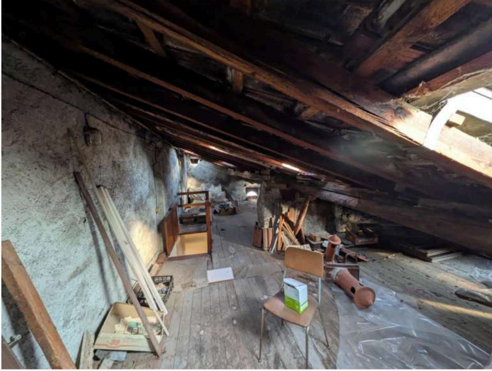
Foto 17 – sottotetto a sgombero Lotto 2
