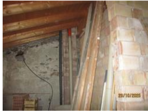
sottotetto lato nord est
