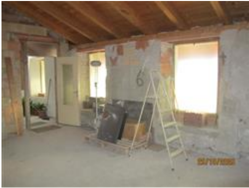
p.ed. 672/2 p.m. 3 - sottotetto lato sud ovest
