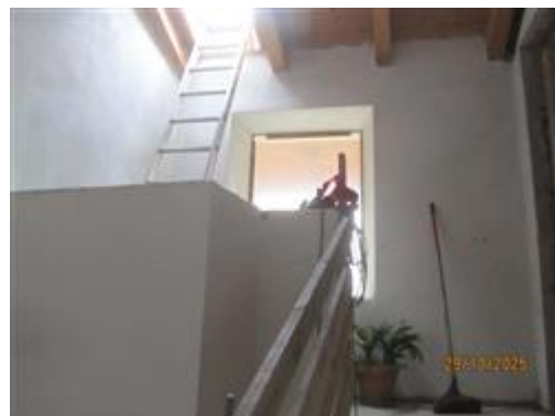
vano scala di accesso al piano di sottotetto
