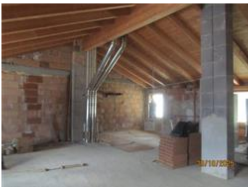
sottotetto lato nord ovest
