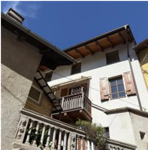
STATO ATTUALE DELLA FACCIATA A SUD
