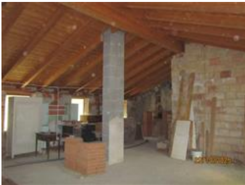
sottotetto lato nord est
