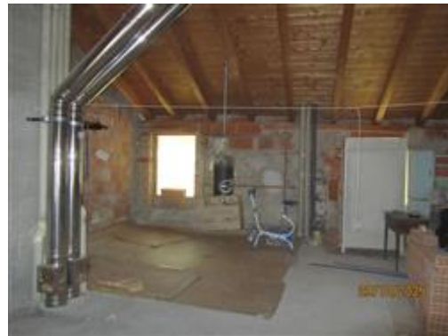
sottotetto lato nord ovest
