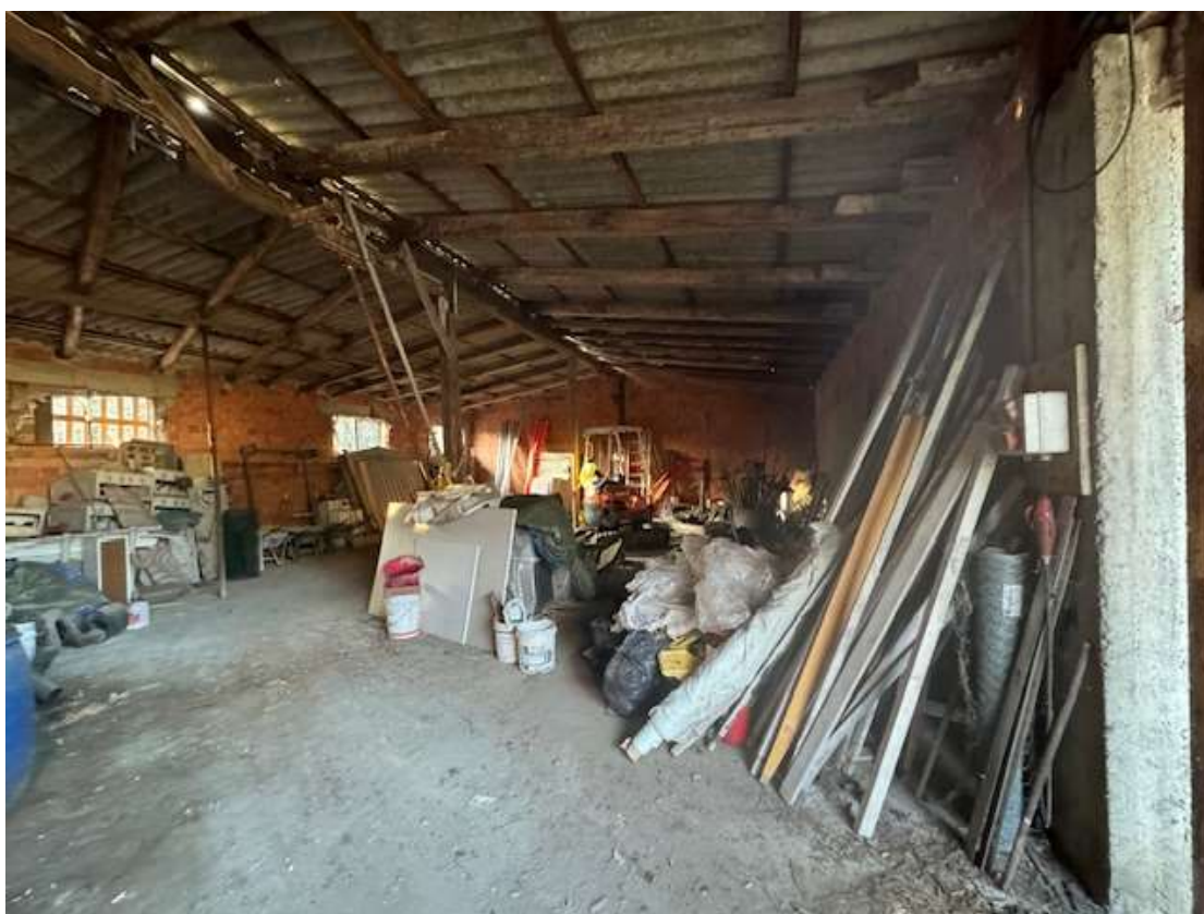
Lotto 3, Corpo 1 - Vista interna (Subalterno 2)
