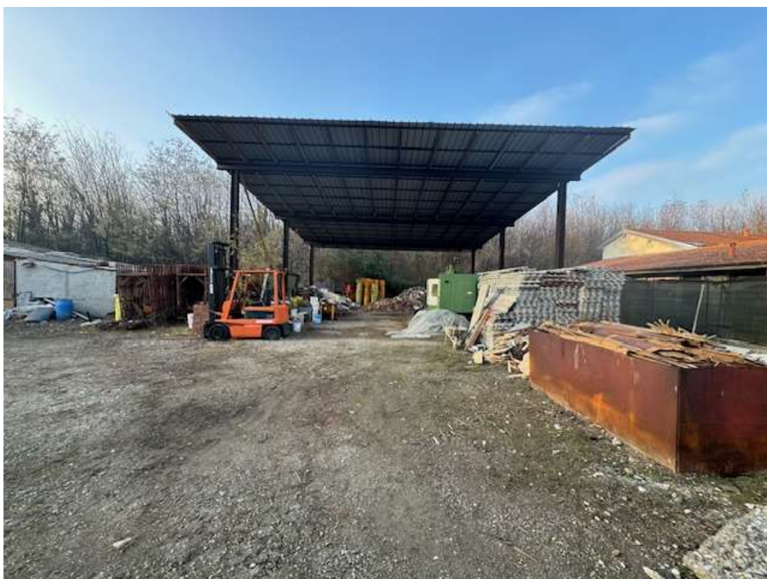
Lotto 3, Corpo 3 - Vista esterna (Subalterno 4)
