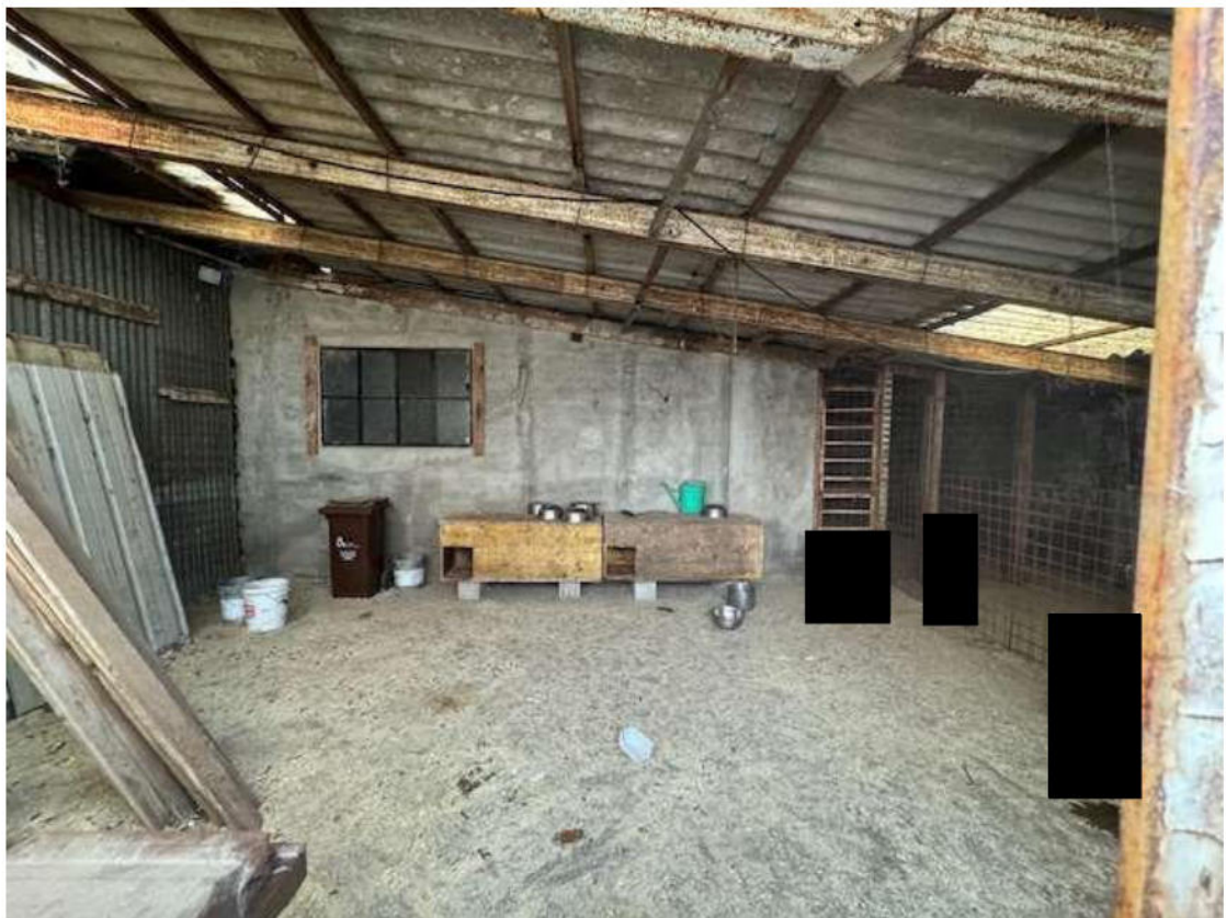
Lotto 3, Corpo 2 - Vista interna (Subalterno 3)
