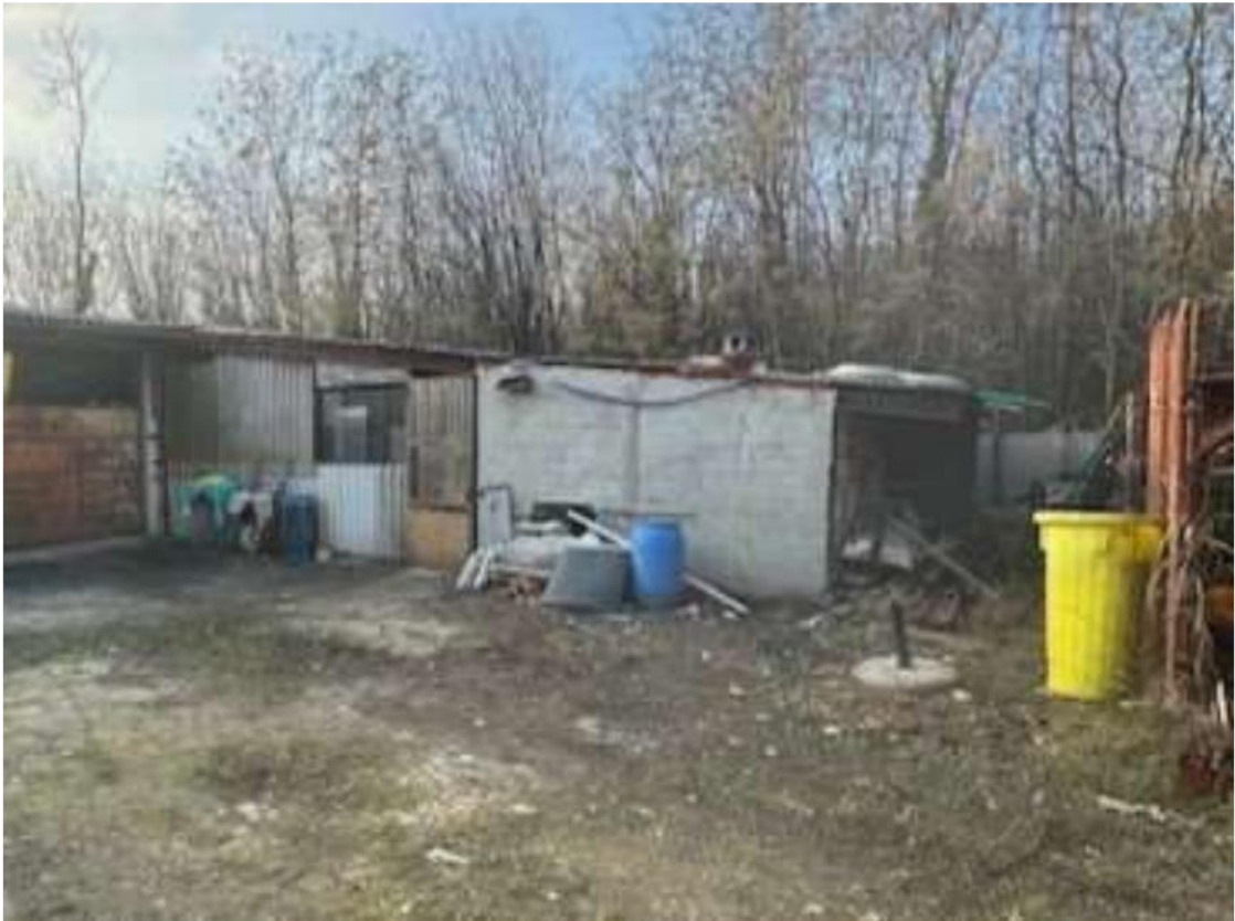
Lotto 3, Corpo 2 - Vista esterna (Subalterno 3)
