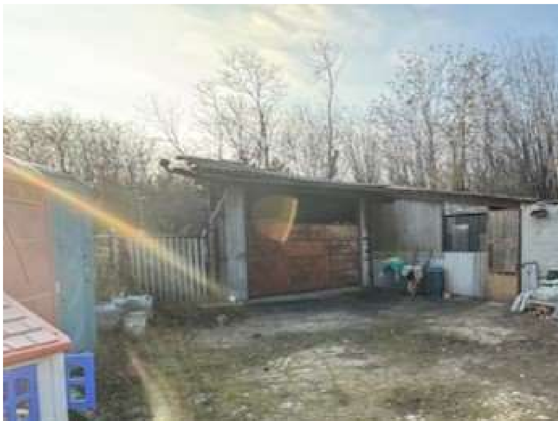
Lotto 3, Corpo 1 - Vista esterna (Subalterno 2)
