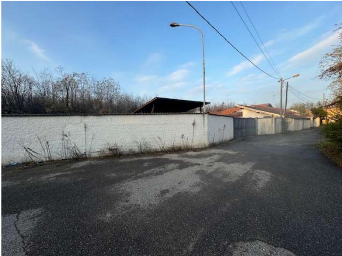
Lotto 3 - Ingresso da via Cascina Tangitt
