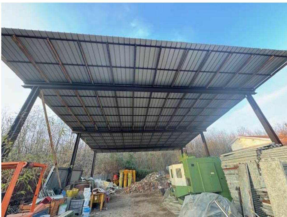
Lotto 3, Corpo 3 - Vista esterna (Subalterno 4)
