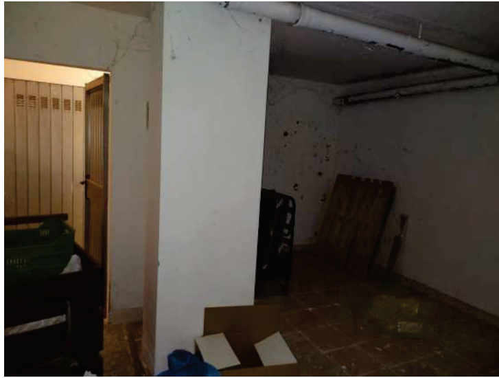
FIGURA 10: Vista della cantina sub 27 dal fondo verso l'ingresso
