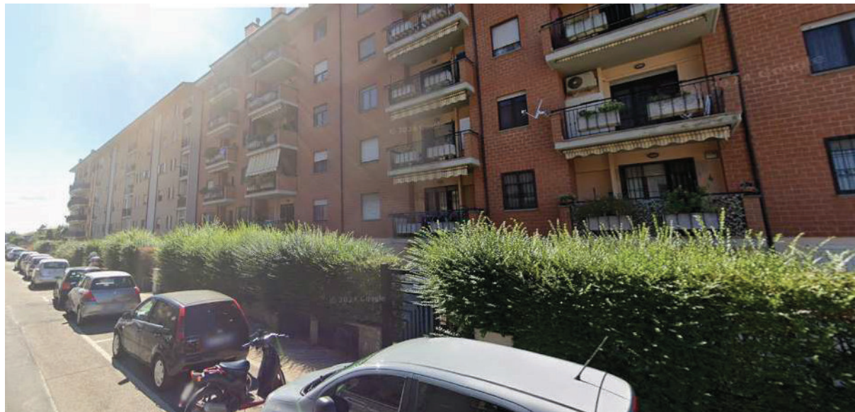
FIGURA 3: Vista degli edifici in via Del Verrocchio
