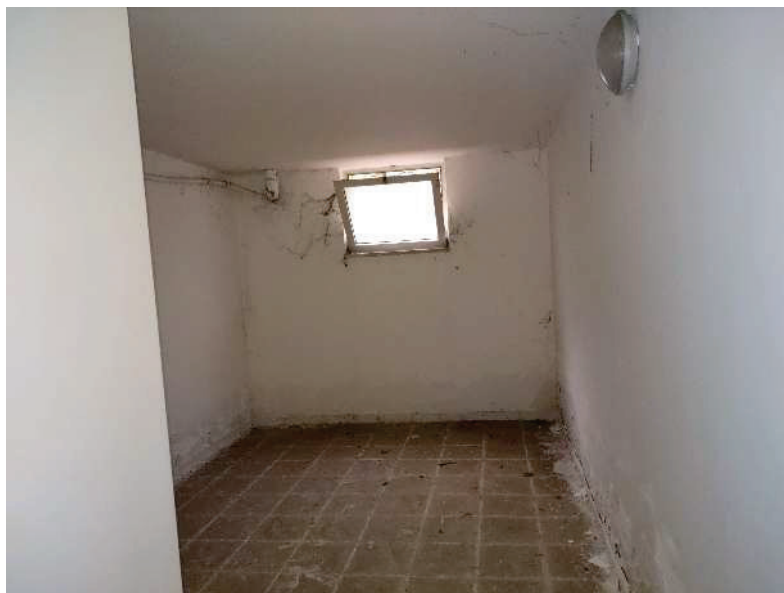
FIGURA 7: Vista della cantina sub 22 dall'ingresso verso il fondo
