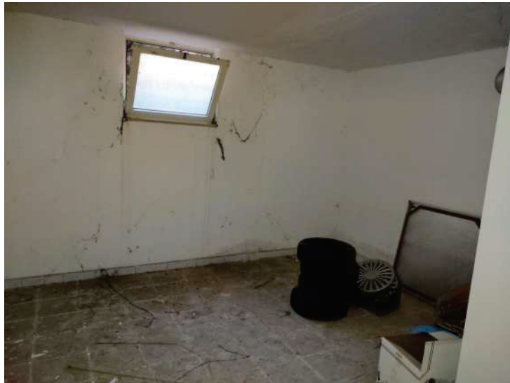
FIGURA 11: Vista della cantina sub 27 dall'ingresso verso il fondo
