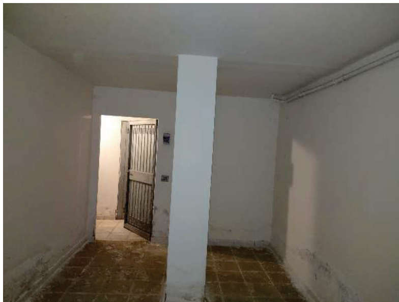
FIGURA 6: Vista della cantina sub 22 dal fondo verso l'ingresso
