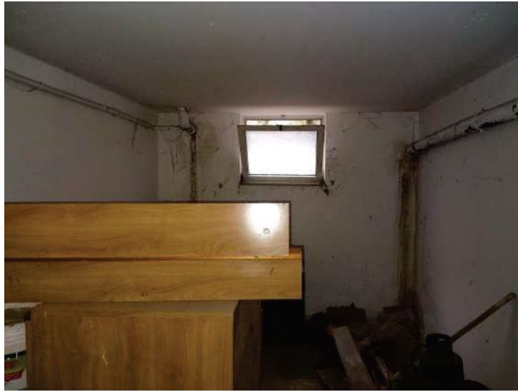
FIGURA 8: Vista della cantina sub 23 dal fondo verso l'ingresso
