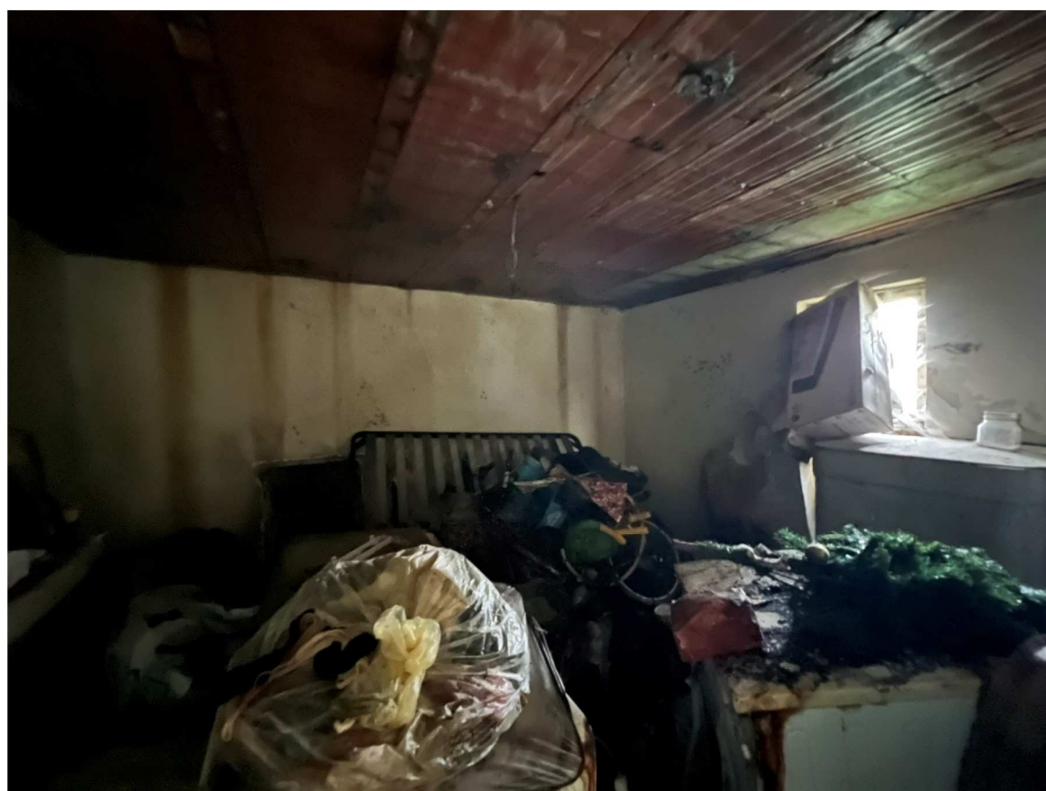
VIA CONFINE 50 – CONCORDIA SULLA SECCHIA (MO) LOC. VALLALTA – INTERNI: CANTINA 2 P. T.
