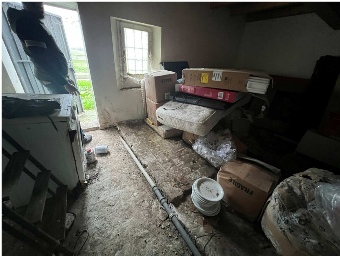
VIA CONFINE 50 – CONCORDIA SULLA SECCHIA (MO) LOC. VALLALTA – INTERNI: CANTINA 3 P. T.
