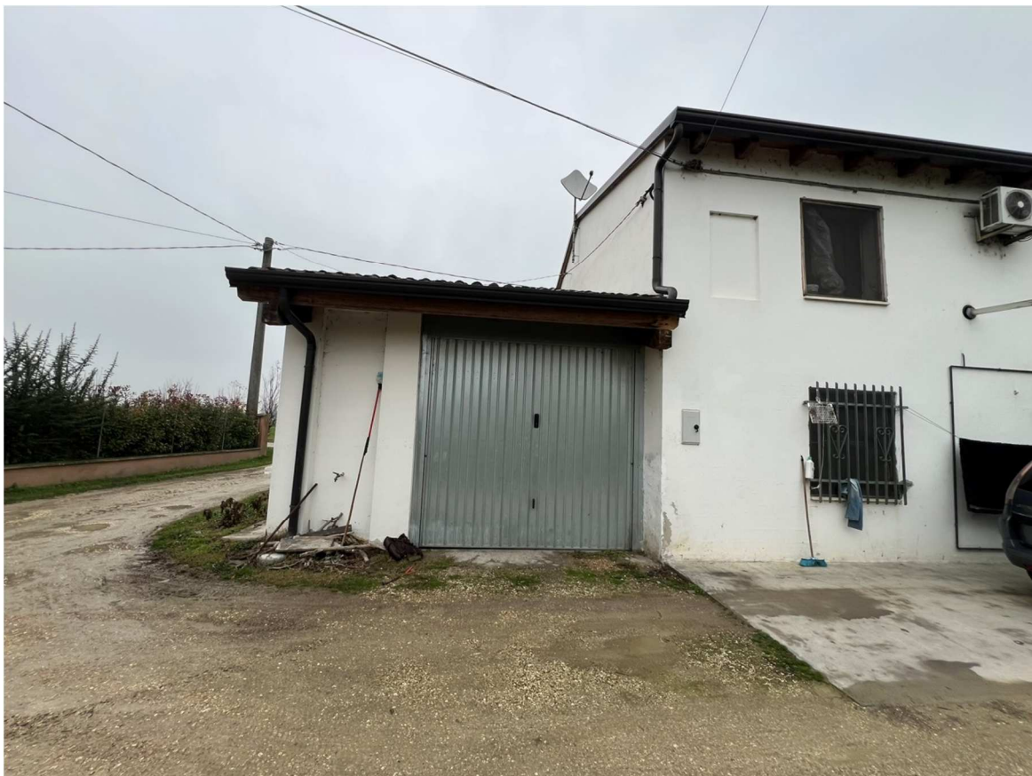
VIA CONFINE 50 – CONCORDIA SULLA SECCHIA (MO) LOC. VALLALTA - ESTERNO
