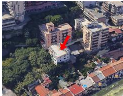
Immagine satellitare del fabbricato
