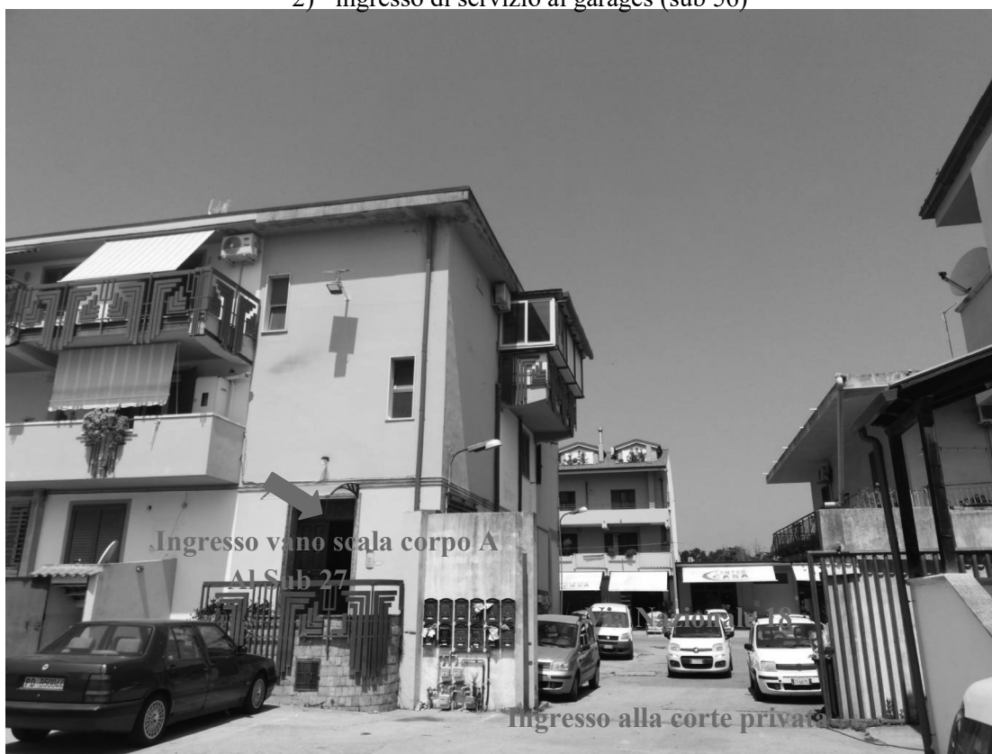
Foto 4_ vista dall'esterno – ingresso scala condominiale corpo A
