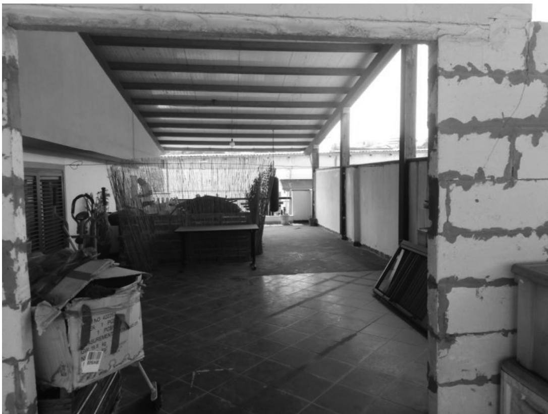
Foto 19 : terrazza coperta con tettoia
