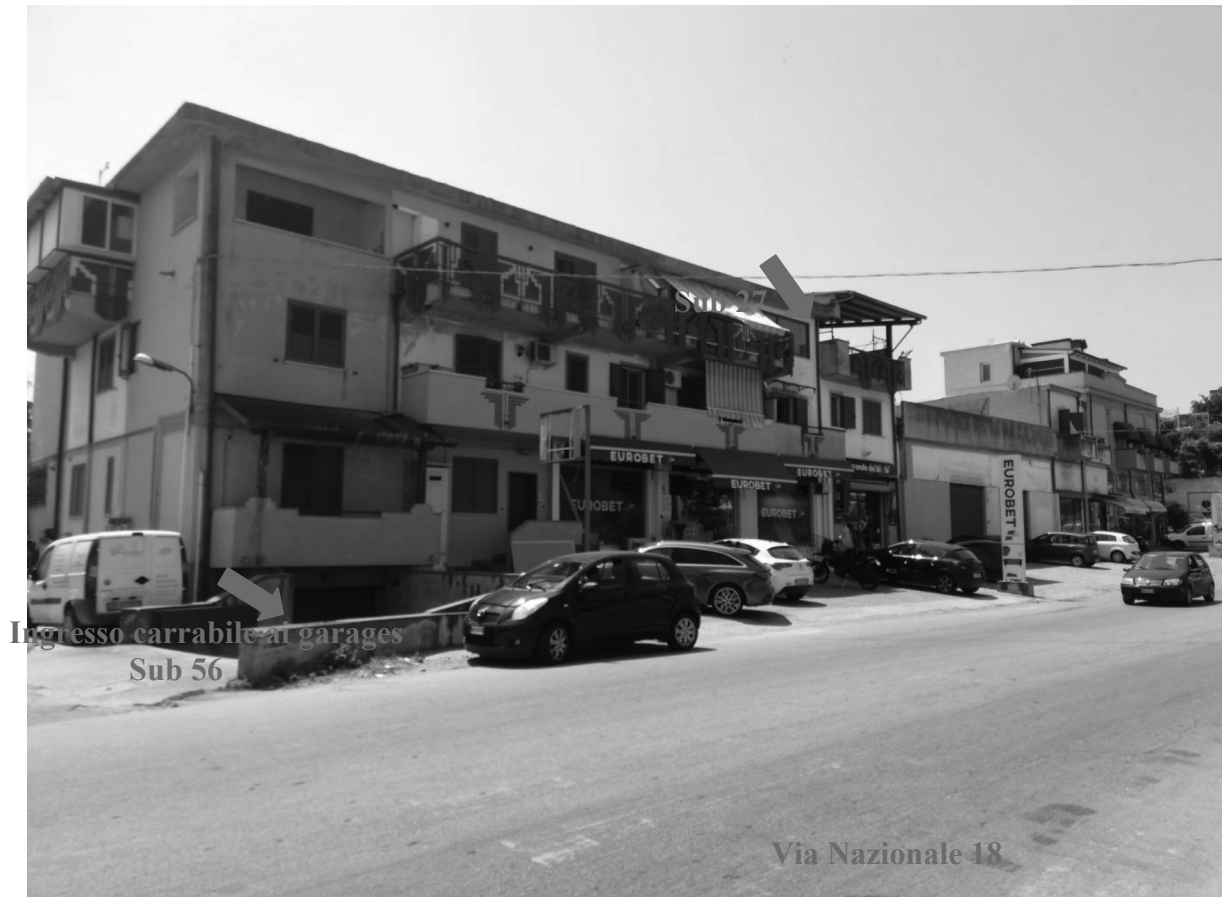
Foto 2_ vista dall'esterno – dalla via Nazionale 18
