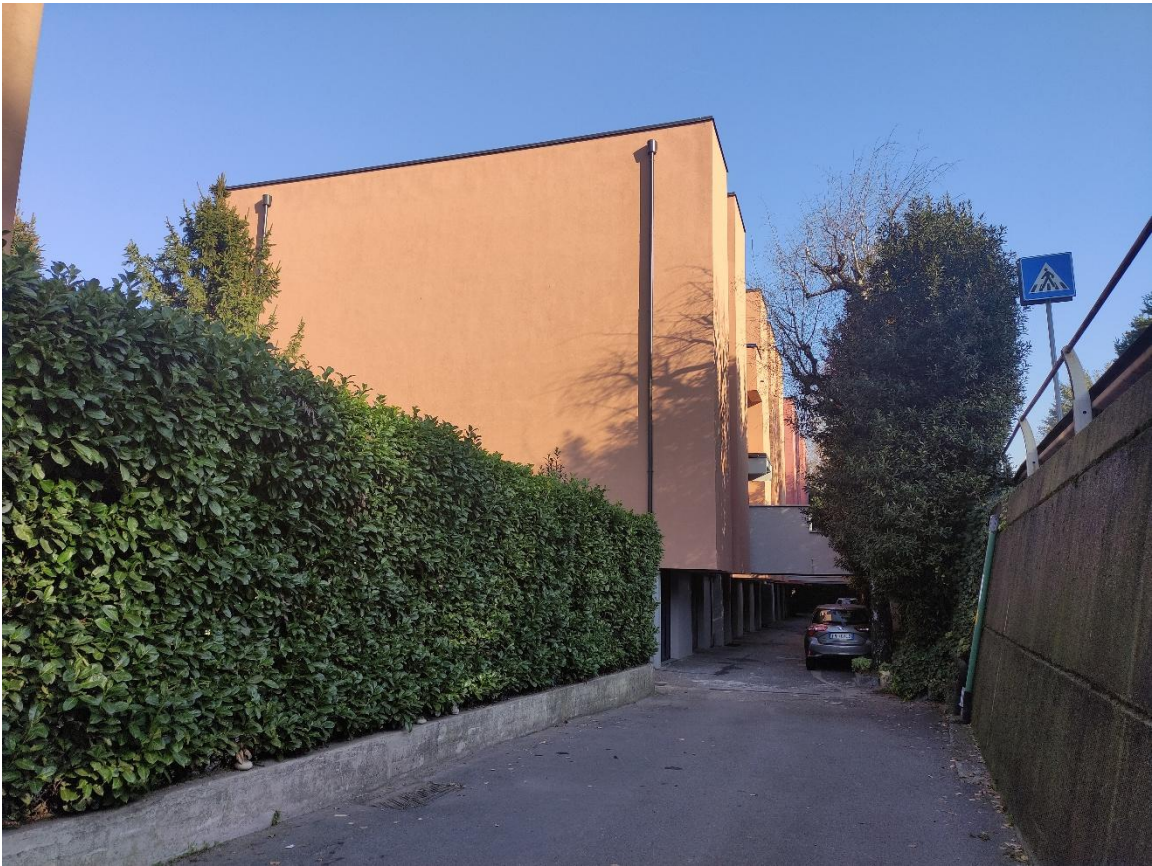
Facciata sud e sud-ovest ed ingresso carraio
