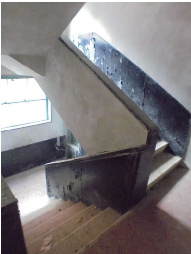
Foto 48 - Vista del vano scale di servizio
