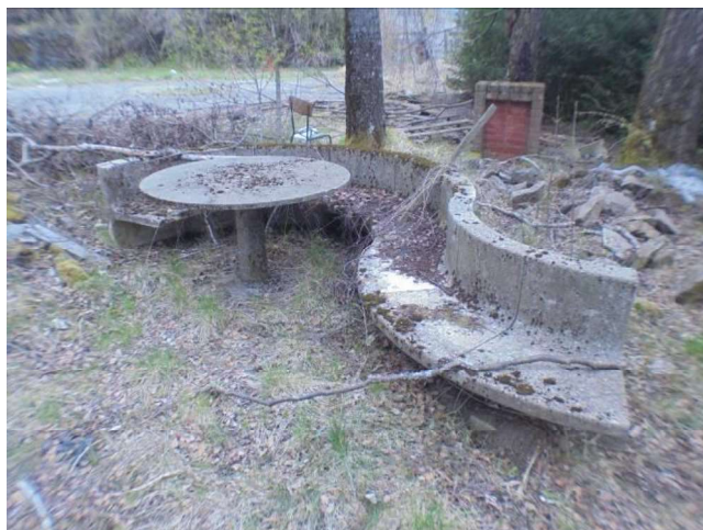
Foto da 96 a 99 - Sistema di tavoli e sedute a "misura di bambino" originali dell'epoca (anni '40) in calcestruzzo prefabbricato (sistema modulare) posizionati nel giardino, zona di ingresso.
