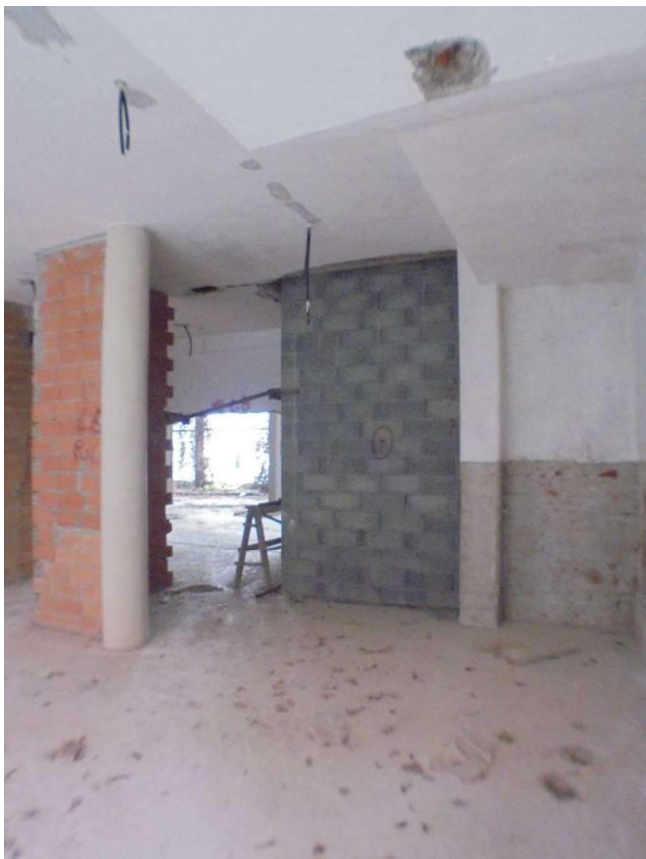
Foto 32 - Vista della zona di disimpegno degli ascensori
