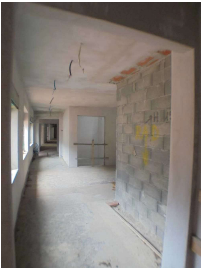
Foto 67 - Vista del pianerottolo ascensori
