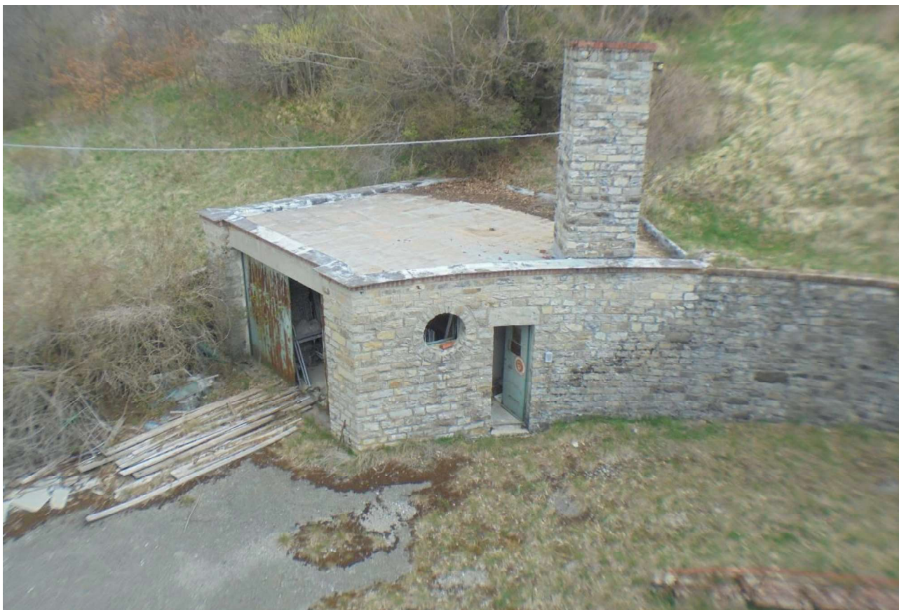
Foto 91 – Foto di insieme del locale tecnico/autorimessa (Edificio 3)
