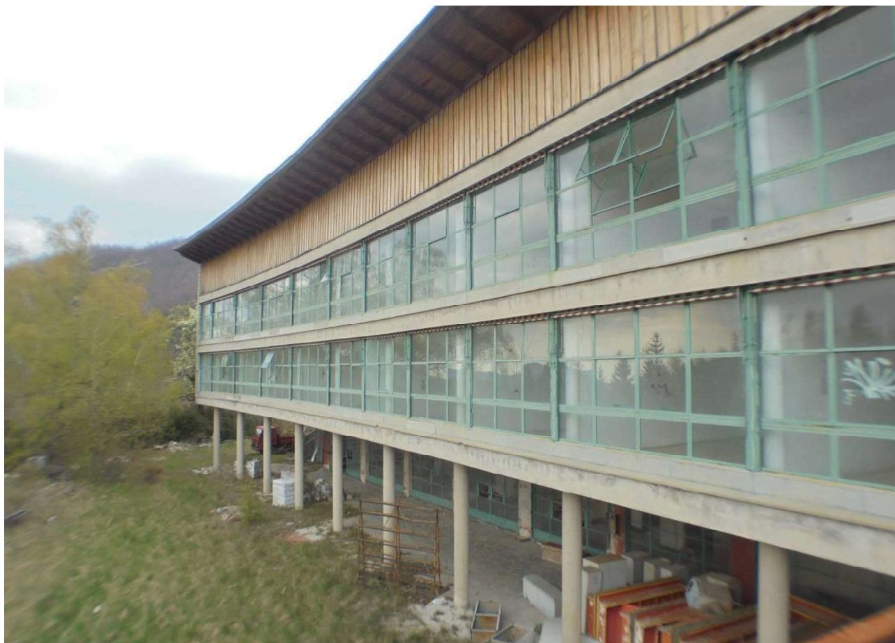
Foto 44 – Vista della terrazza panoramica dell'ala SX dell'Edificio 1
