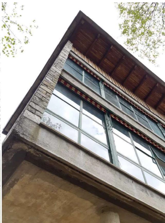
Foto 11 - Vista di dettaglio della facciata dell'Edificio 1
