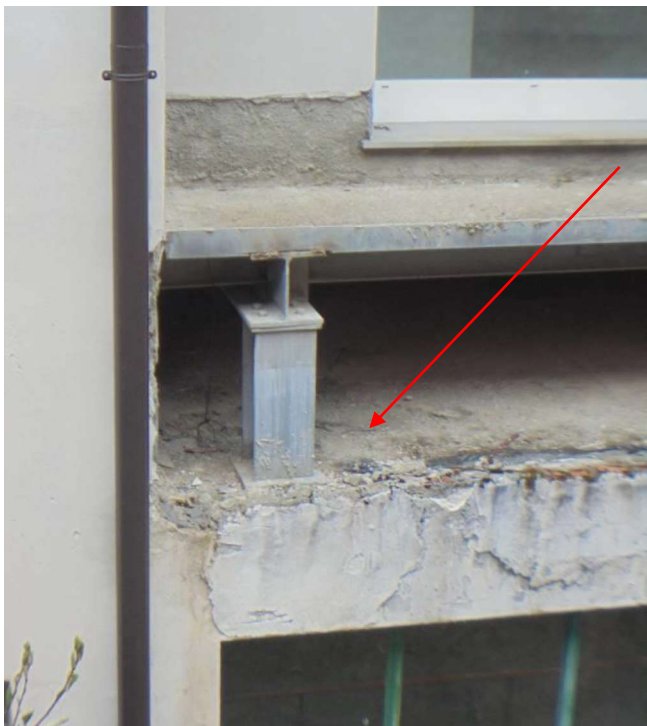
Foto 60 – Dettaglio di una parte strutturale
