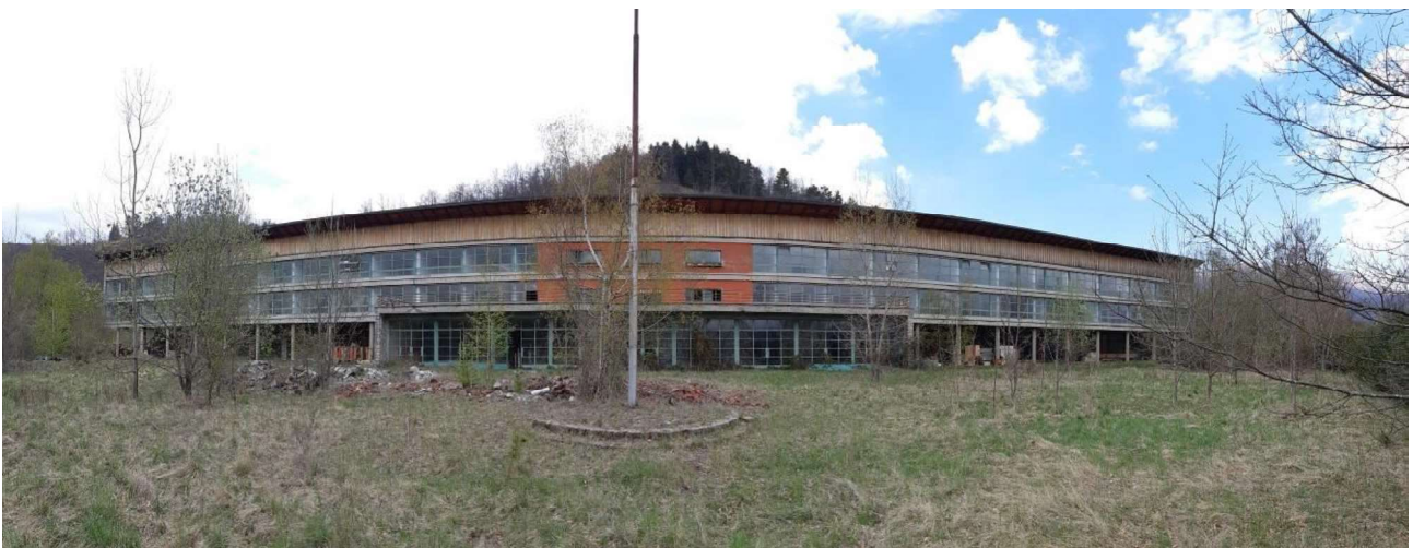
Foto 8 – Vista panoramica dell'Edificio 1
