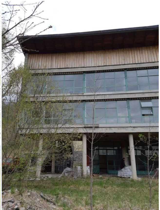
Foto 13 - Vista di dettaglio della facciata dell'Edificio 1
