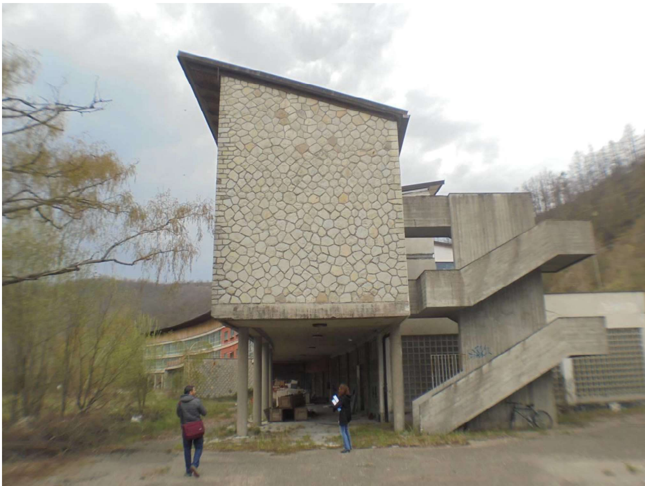
Foto 16 - Vista del prospetto DX dell'Edificio 1
