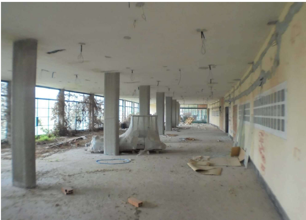
Foto 29 – Vista dell'ex refettorio centrale
