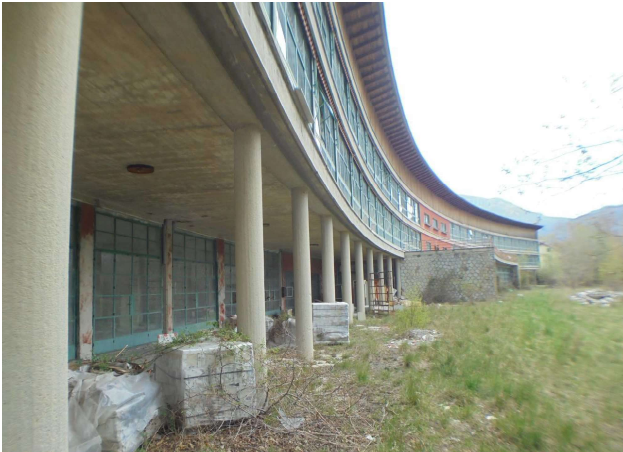
Foto 27 – il patio dell'ala SX dell'edificio
