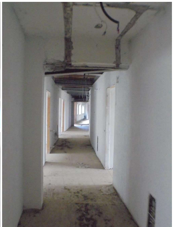
Foto 66 – Vista del corridoio di disimpegno (ala DX) di collegamento agli alloggi da 2 camere di degenza del piano 2°
