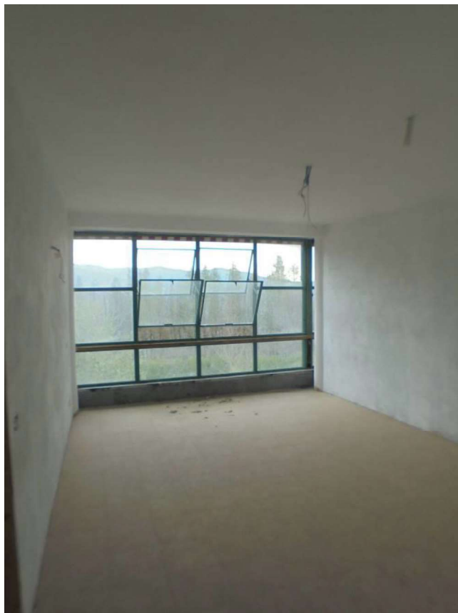
Foto 68 – Vista di una delle stanze degli alloggi da 2 camere di degenza del piano 2°
