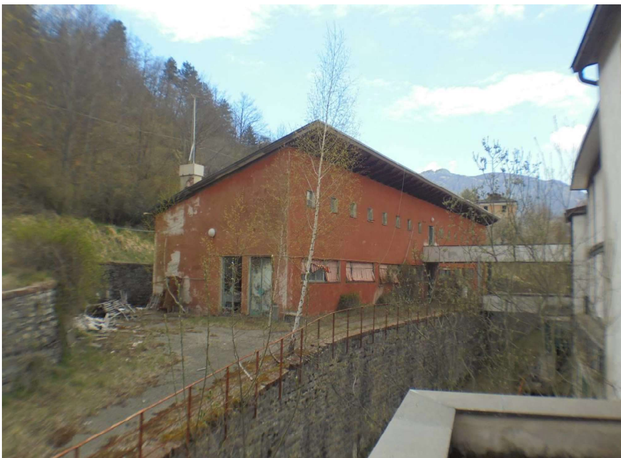
Foto 81 e 82 – Foto di insieme del corpo dell'Edificio 2
