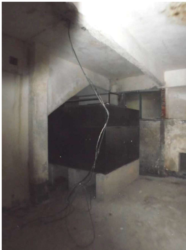
Foto 73 – Vista del serbatoio ex centrale termica
