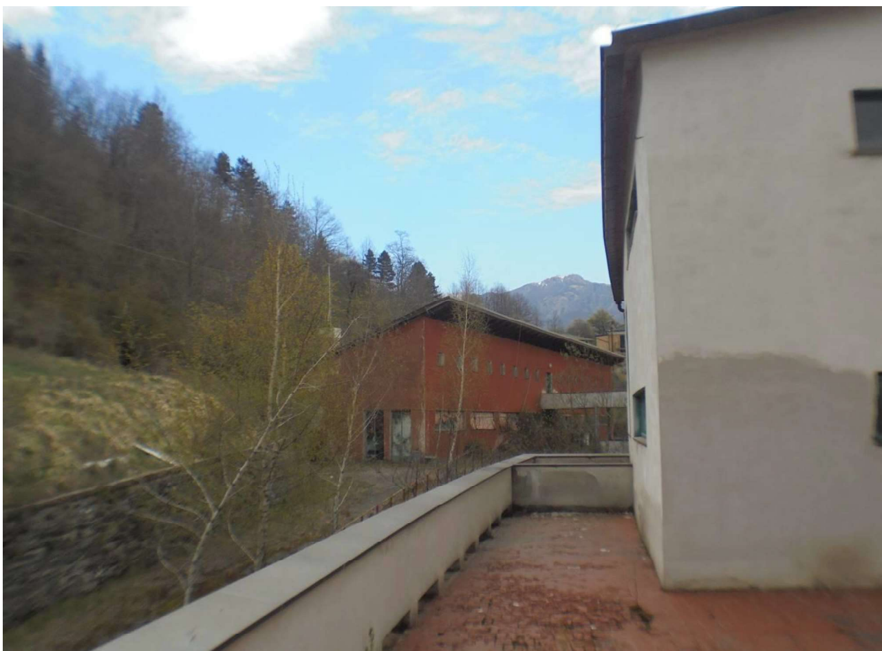
Foto 63 - Vista dalla terrazza lato monte dell'Edificio 2
