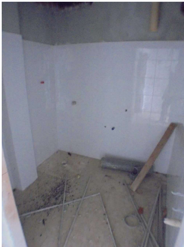
Foto 51 – Vista di uno di un bagno tipo dedicato alla camera singola
