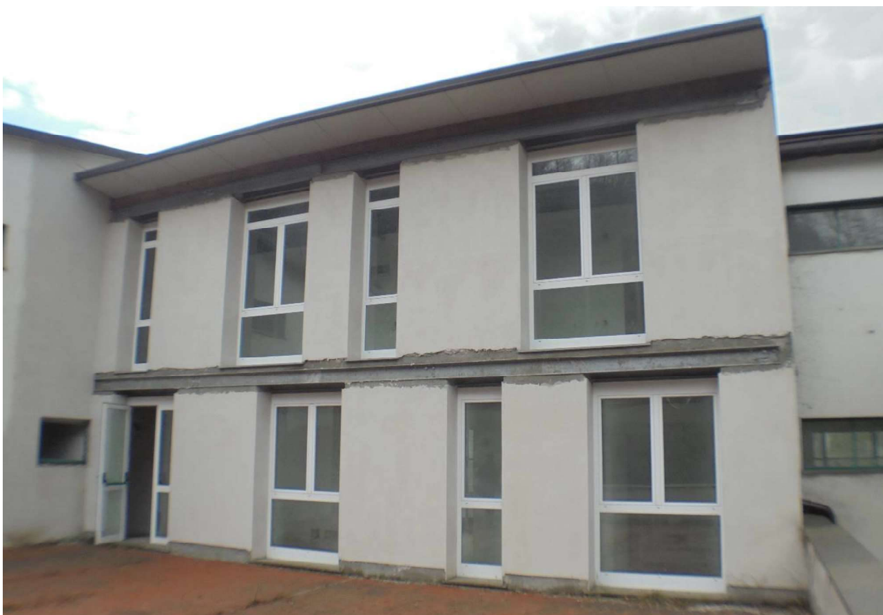
Foto 61 - Vista di uno dei 4 volumi realizzati sul progetto del '97 in corrispondenza della terrazza
