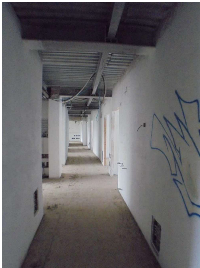
Foto 49 – Vista del corridoio di disimpegno (ala SX) di collegamento alle camere singole di degenza del piano 1°
