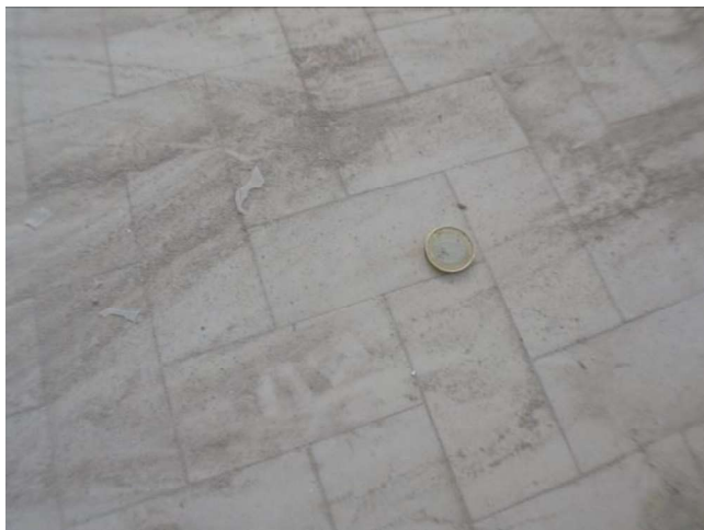
Foto 35 - Dettaglio del pavimento originale in gress porcellanato
