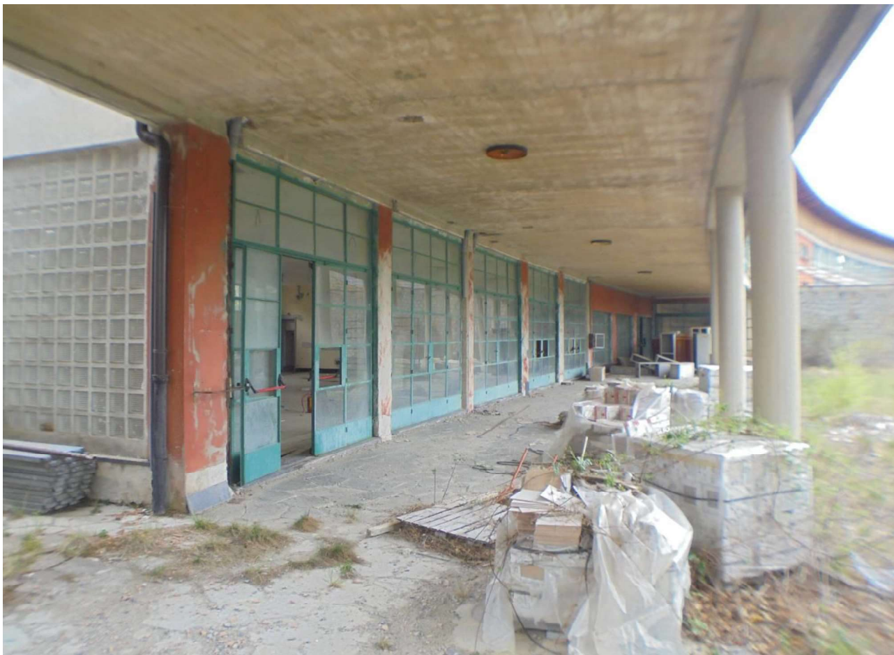
Foto 26 – il patio dell'ala SX dell'edificio
