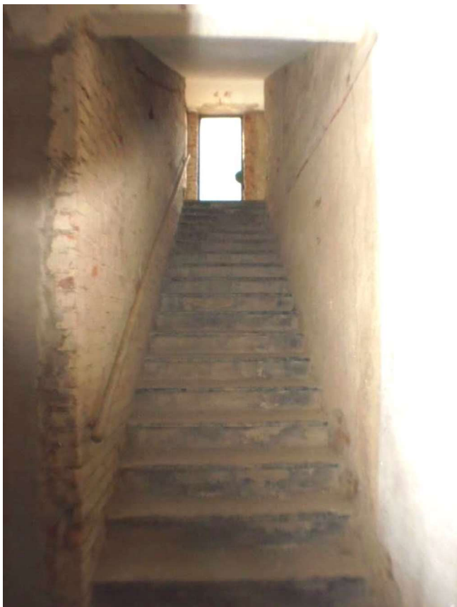
Foto 72 - Vista della scala di servizio
