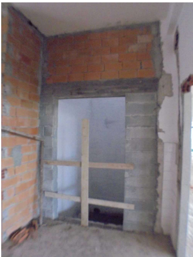
Foto 34 - Vista del vano ascensore
