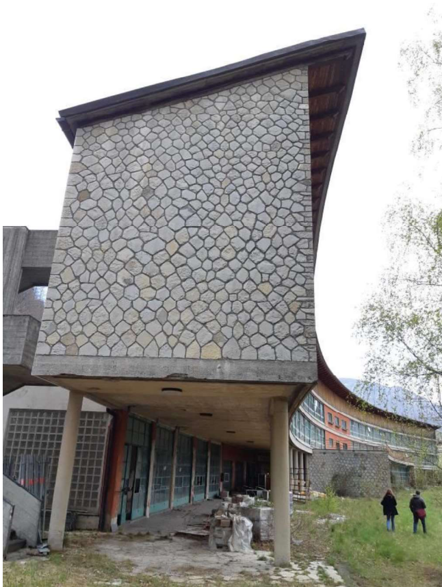
Foto 12 - Vista del prospetto SX dell'Edificio 1
