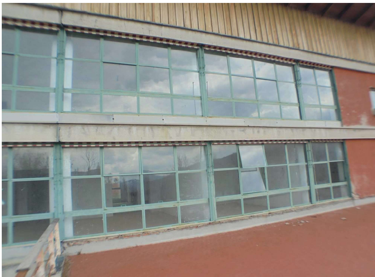
Foto 45 – Dettaglio delle finestre a bilico
