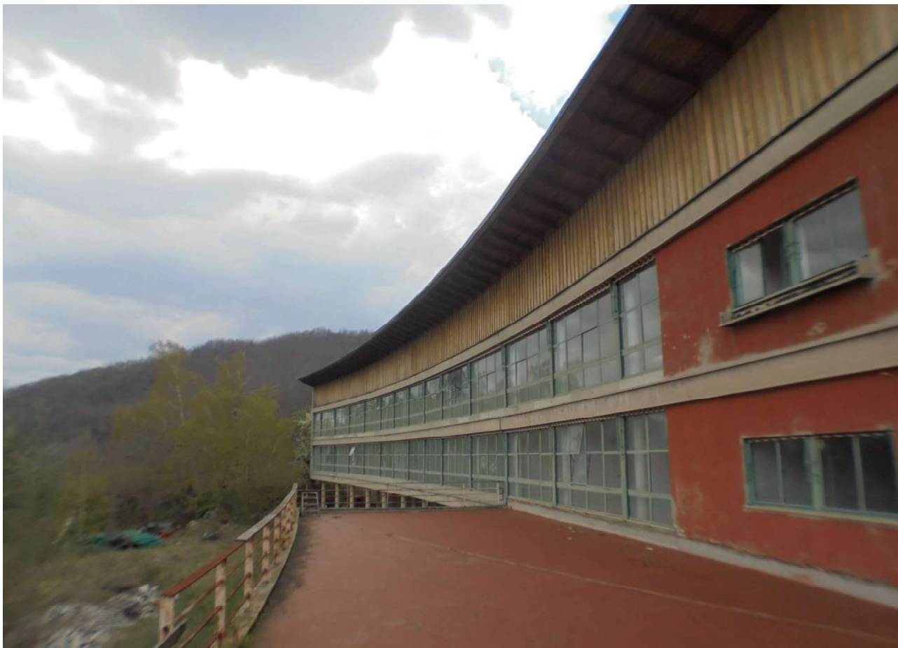
Foto 42 – Vista della terrazza panoramica dell'ala SX dell'Edificio 1
