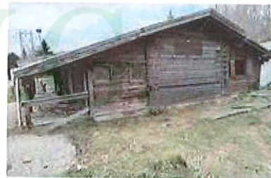
FOTO 6 - vista del viale della casa e del magazzino, dal lato della strada
