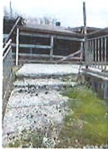
FOTO 3 - vista del viale della casa e del magazzino
