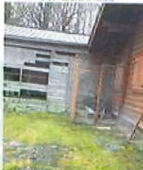
FOTO 5 - vista del viale della casa e del magazzino, dal lato della strada
