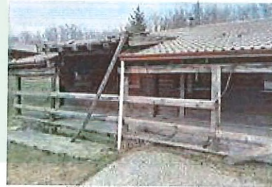
FOTO 4 - vista del viale della casa e del magazzino, dal lato della strada
