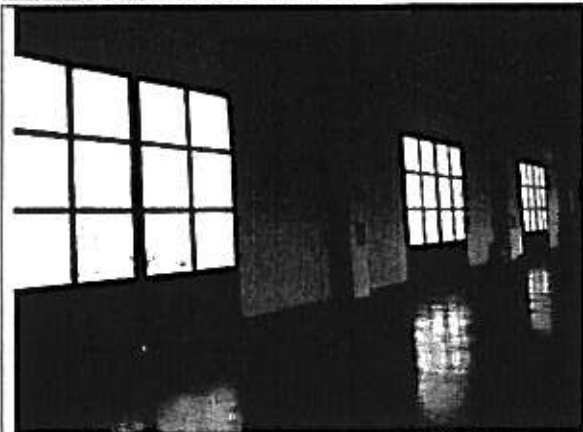
Foto 3 – Vano (ufficio industriale)
