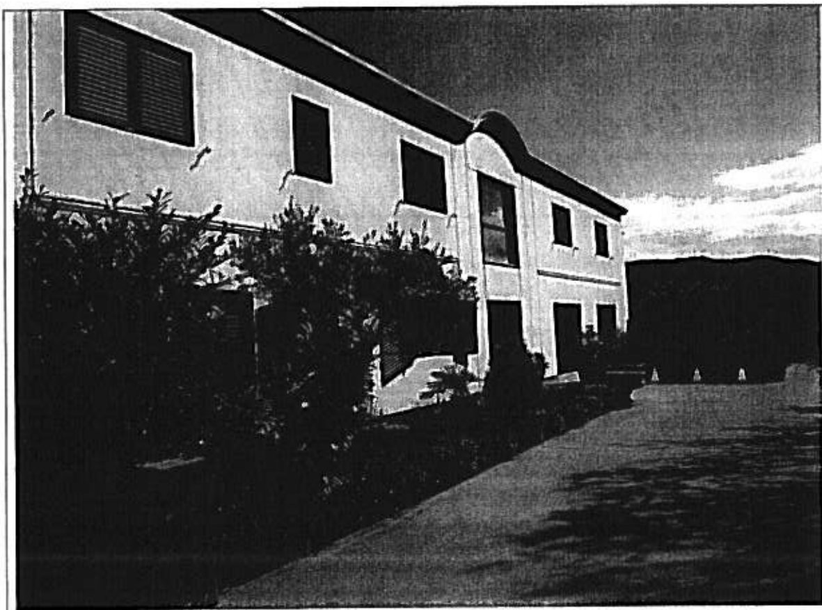
Foto 4 - Facciata esterna lato sud (l'appartamento è ubicato al piano 1°)
