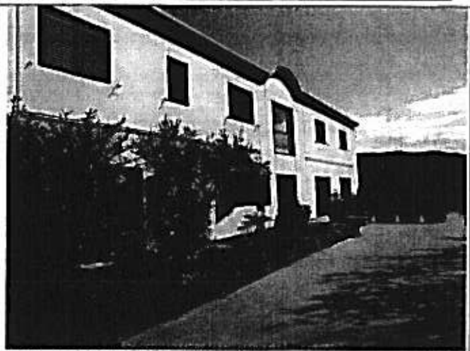
Foto 8 - facciata esterna lato sud uffici e officina
