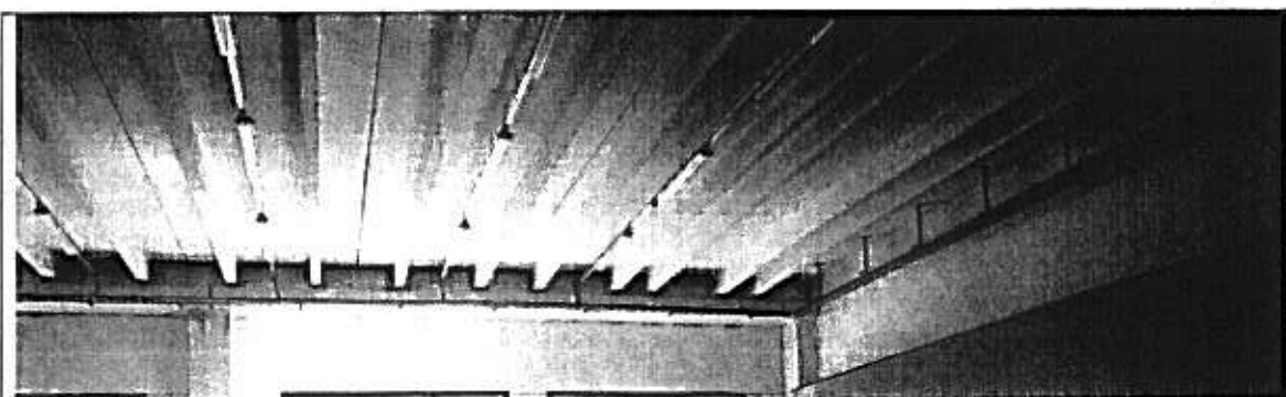
Foto 4 – Vano (ufficio industriale)
