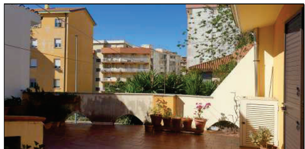
LA TERRAZZA E IL VANO CALDAIA
