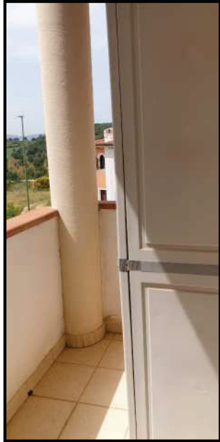
IL BALCONE COPERTO AL PIANO PRIMO
