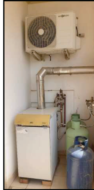
IL BALCONE COPERTO AL PIANO PRIMO
