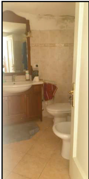
IL SERVIZIO IGIENICO AL PIANO SECONDO
