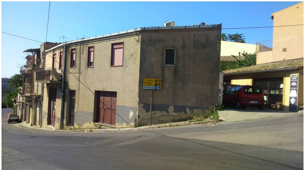
vista su via Balchino fronte principale
