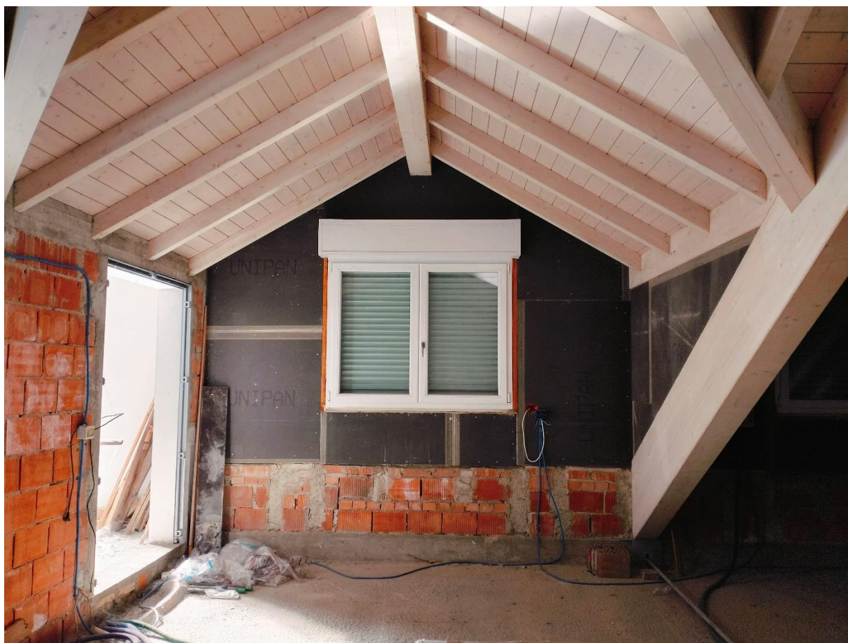
FOTO 22 – P.3°: Ingresso al locale sottotetto
