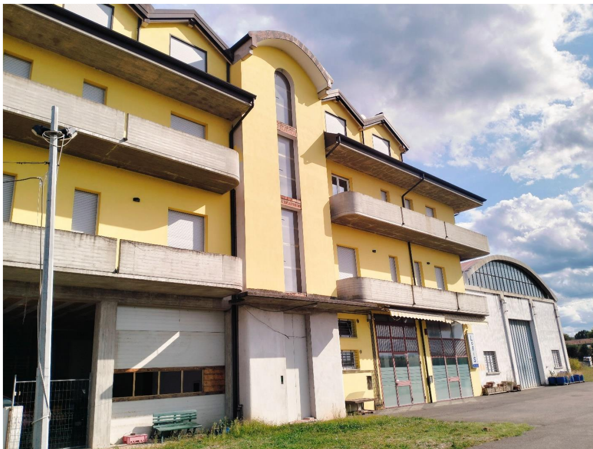
FOTO 3 – Prospetto laterale con ingresso ai piani
