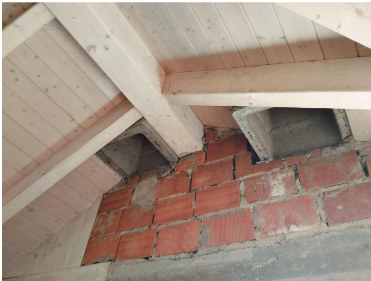
FOTO 25 – P.3°: Locale sottotetto – predisposizione canne fumarie per i camini
