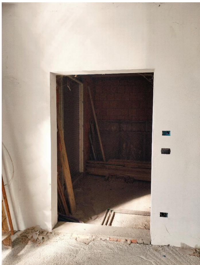
FOTO 7 – P.2°: Pianerottolo piano secondo con ingresso all'appartamento
