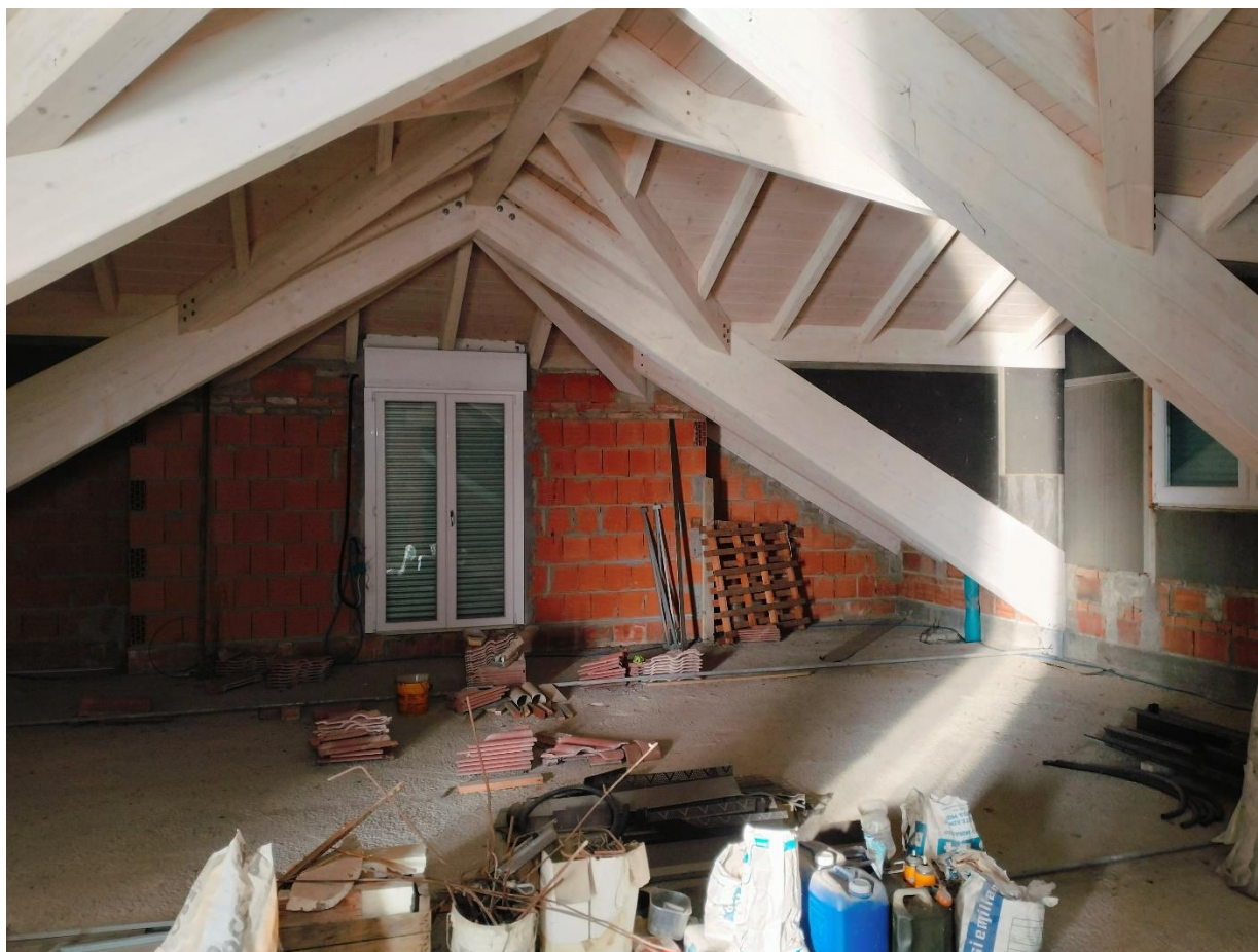
FOTO 23 – P.3°: Locale sottotetto
