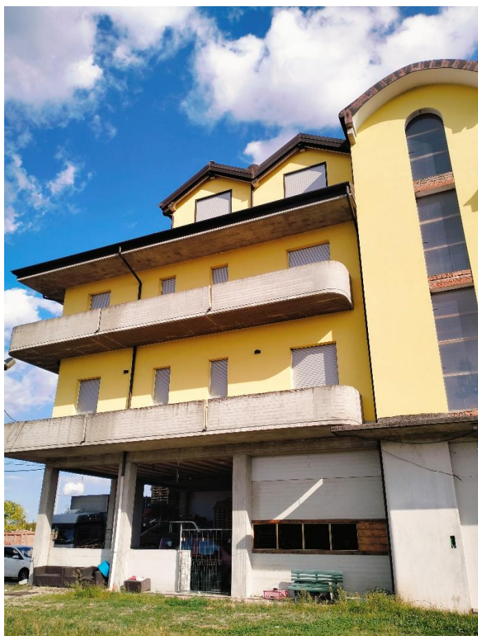
FOTO 4 – Al secondo e terzo piano la proprietà in oggetto
