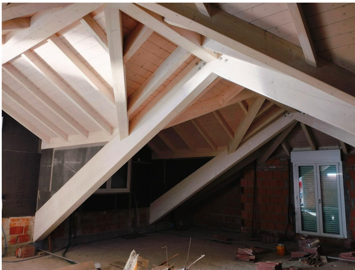
FOTO 24 – P.3°: Locale sottotetto
