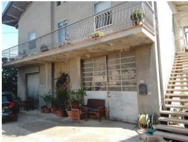
Fronte dell'edificio - ingresso magazzino
