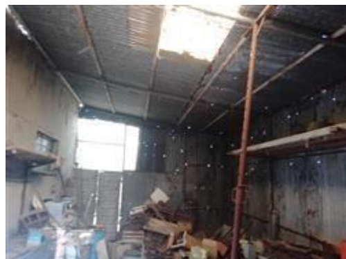
Ripostiglio in lamiera situato al piano terra
