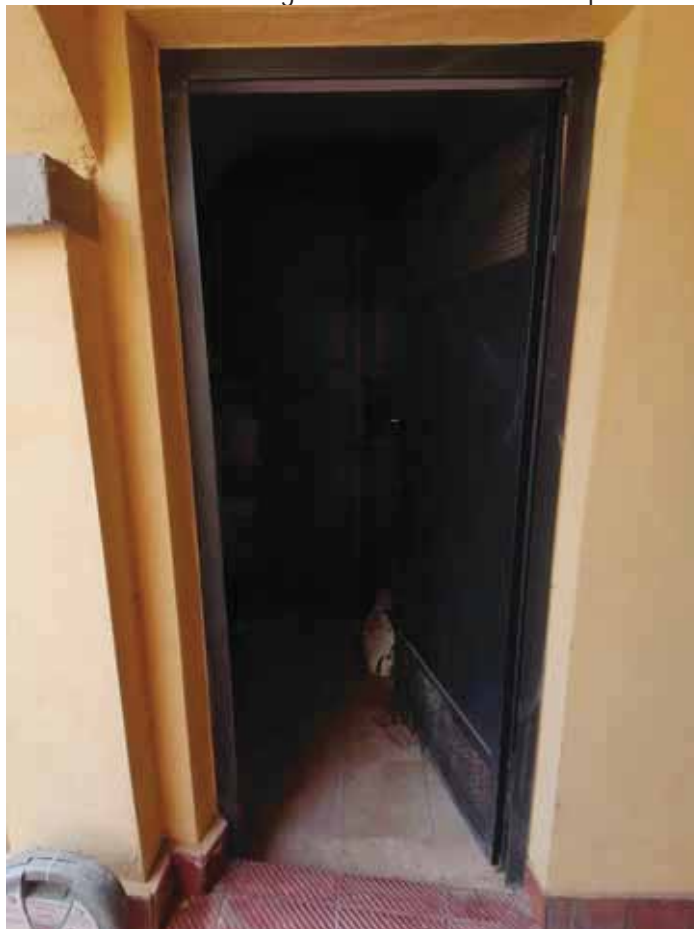
FOTO N°24: Vista esterna dell'ingresso al locale caldaia al piano seminterrato.
