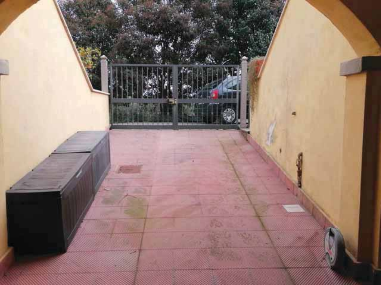
FOTO N°23: Vista esterna del villino al piano seminterrato.
