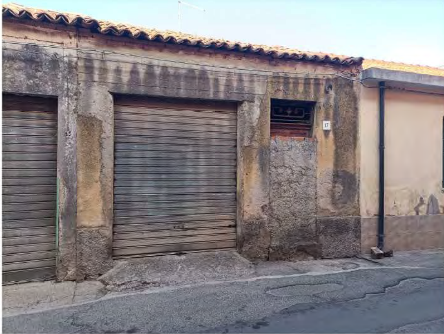
Foto 1 - Prospetto via Fratelli Bandiera
