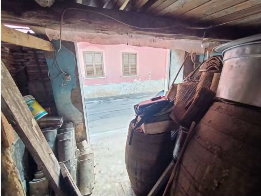
Foto 13 - Vano principale: vista verso via Fratelli Bandiera
