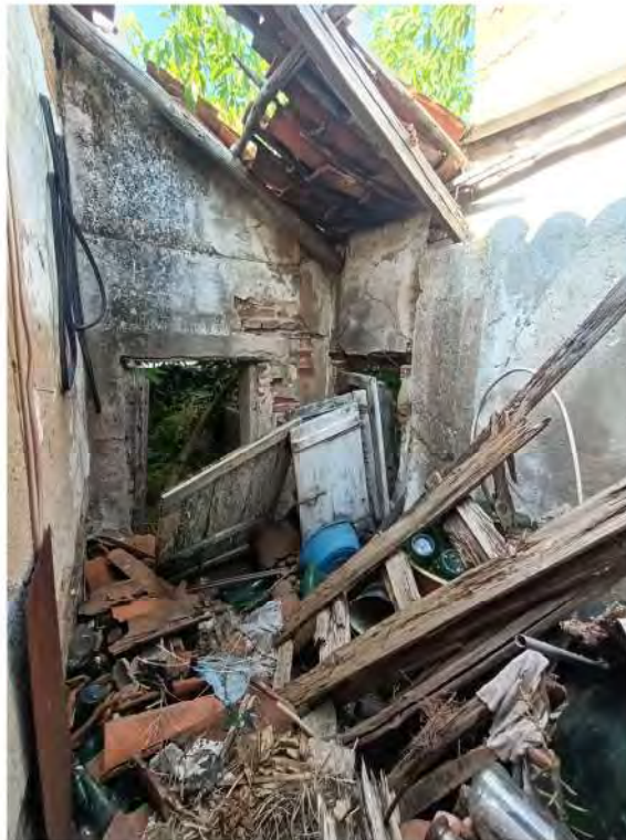
Foto 10 - Vano accessorio con tetto in rovina
