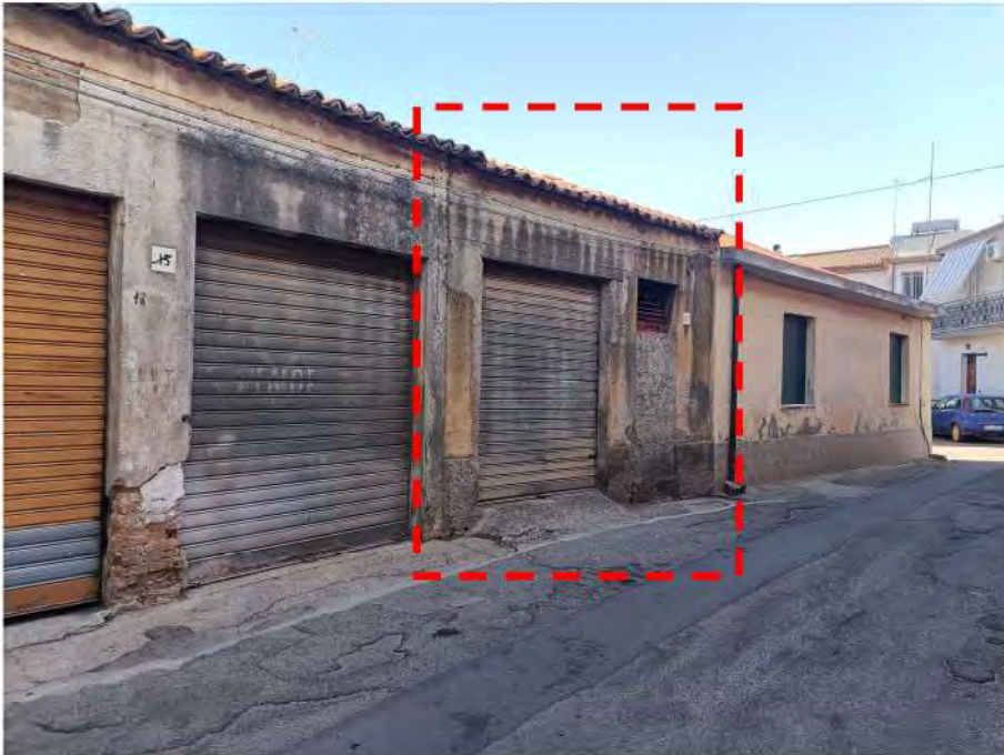
Foto 2 - Prospetto via Fratelli Bandiera
