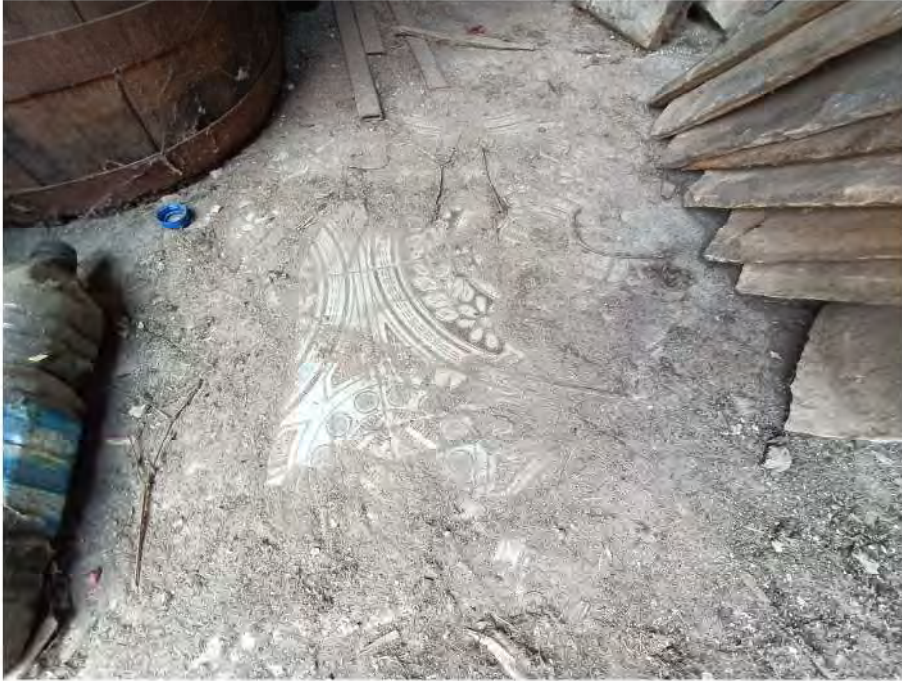
Foto 15 - Vano principale: particolare del pavimento
