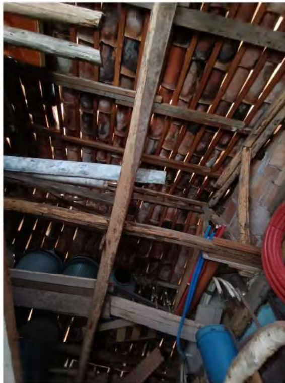
Foto 14 - Vano principale: particolare del soffitto
