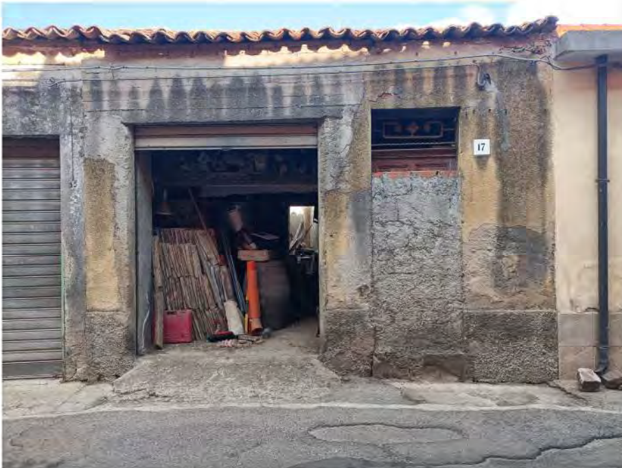
Foto 4 - Prospetto via Fratelli Bandiera
