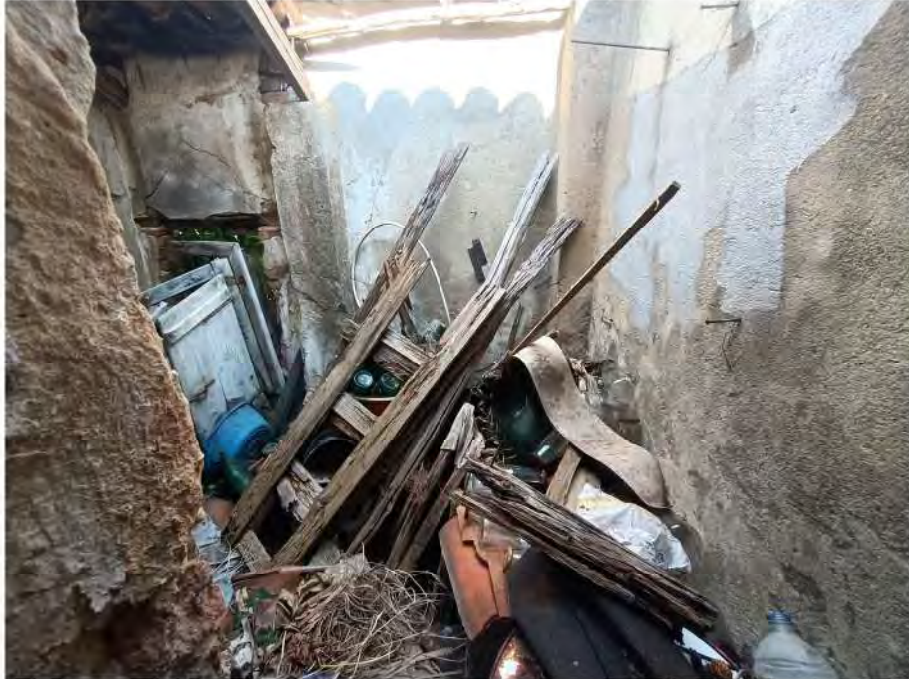
Foto 11 - Vano accessorio con tetto in rovina
