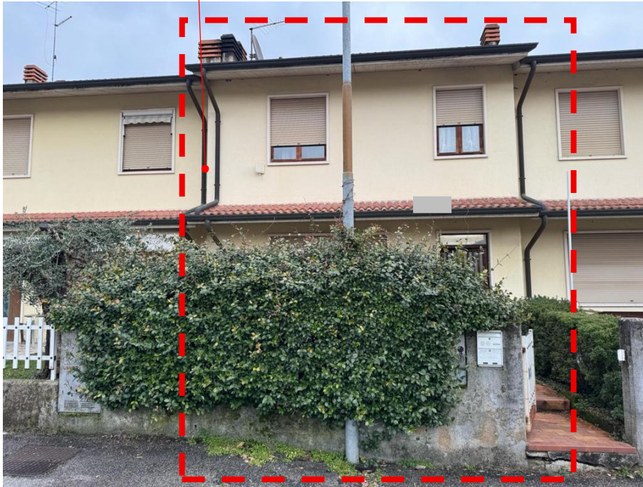
1. – vista panoramica lato Ovest
