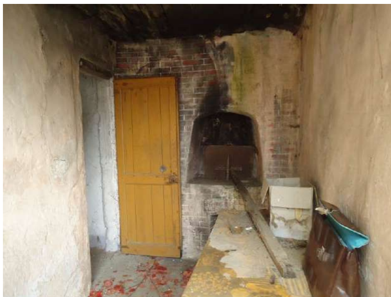
Piano primo Ballatoio con forno Foto n° 40
