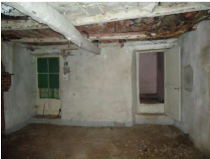
Locale di ingresso Foto n° 42
