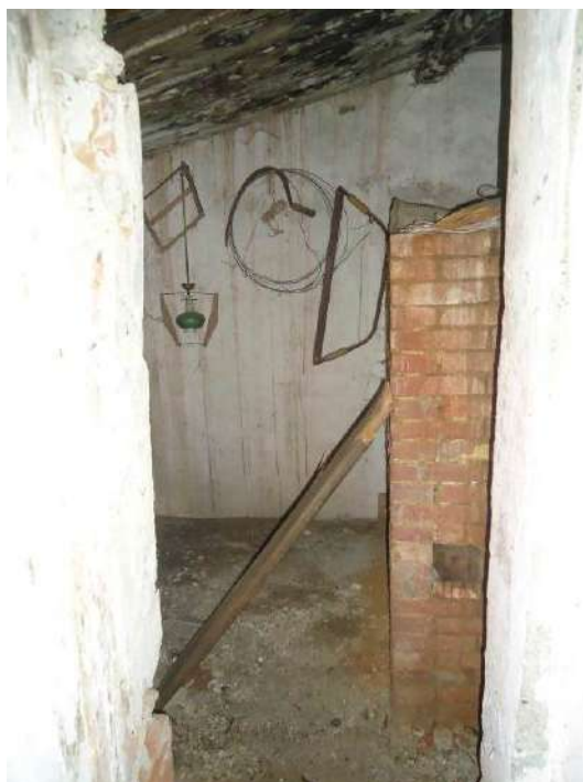
Ripostiglio retro forno Foto n°46
