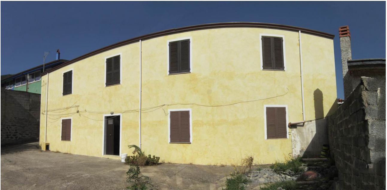
↪ Foto 3, altra vista esterna immobile dal cortile di pertinenza
