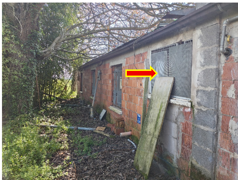
Figura 8: finestrino della centrale termica.
