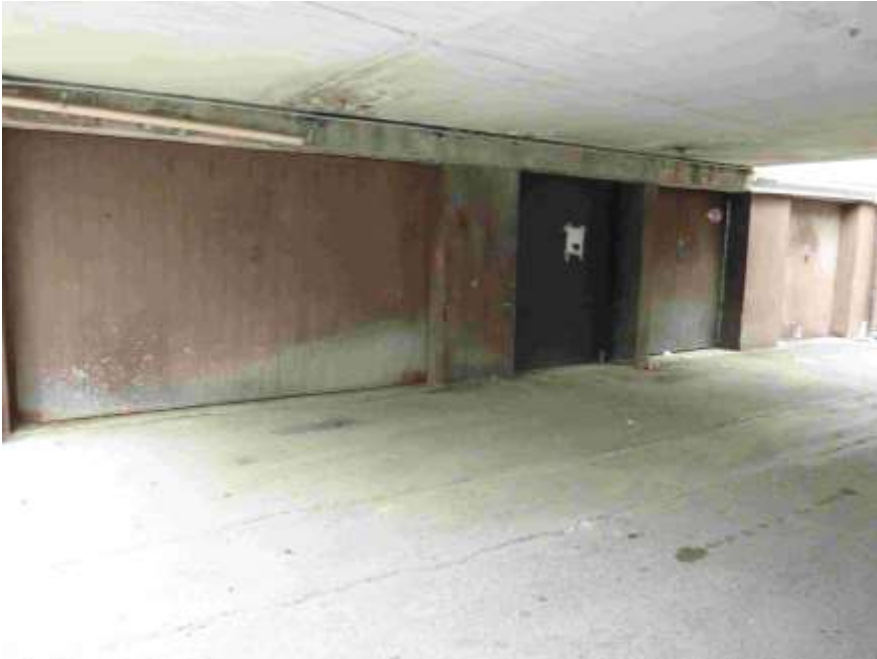
19 – Vista su Corsello di accesso all’Autorimessa
