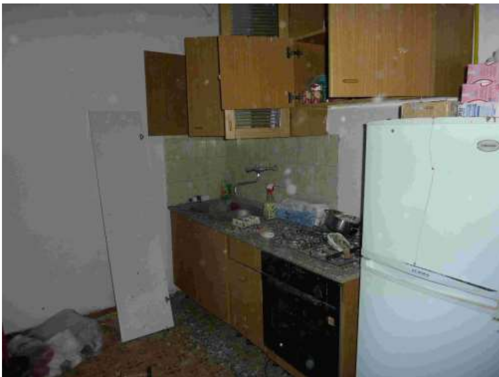
08b – Vista parziale su uso cucina del vano Soggiorno
