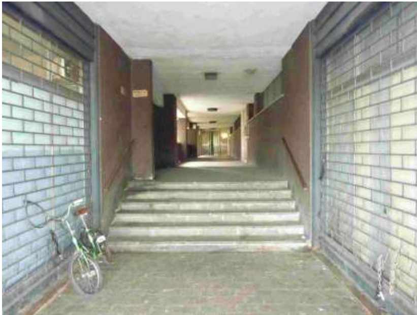
04 – Vista su Porticato comune di accesso al Civico 37
