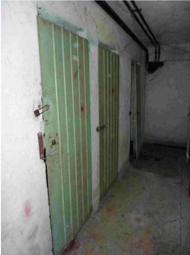
18 – Vista su corridoio comune e porta di accesso al vano Cantina
