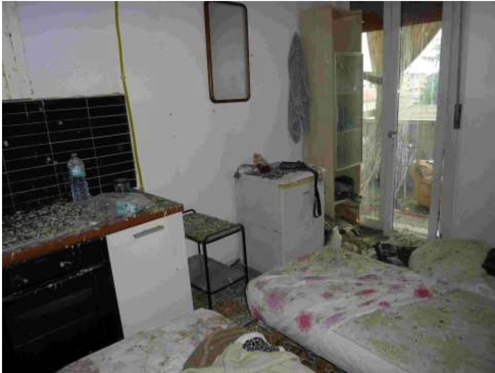
09 – Vista su vano Studio
