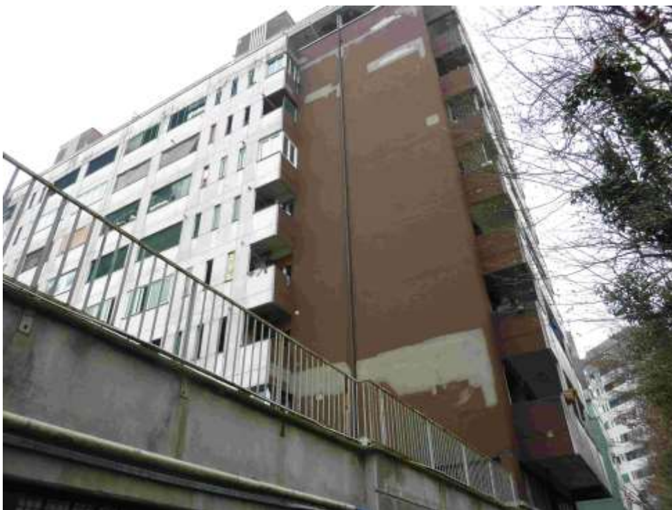
03 – Vista lato Ovest
