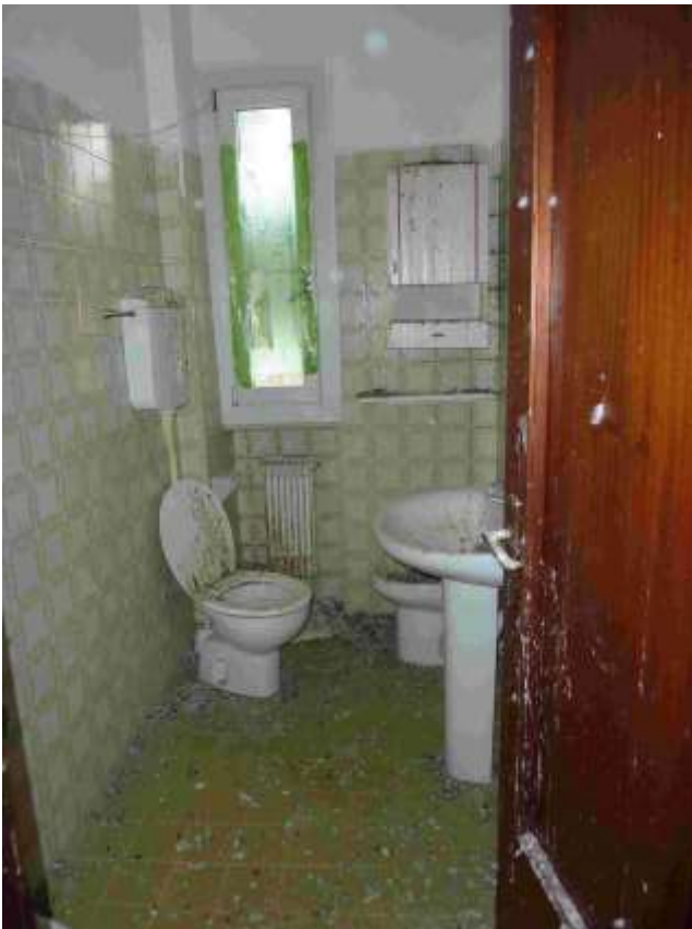
13 – Vista su Vano W.c.
