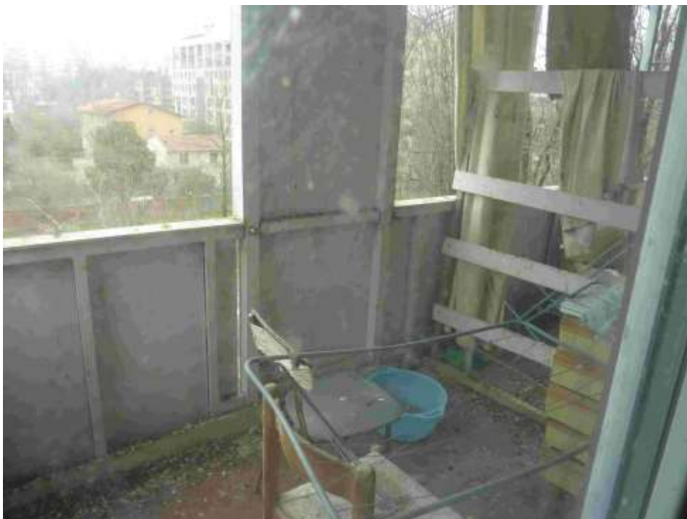
11 – Vista Balcone lato Sud
