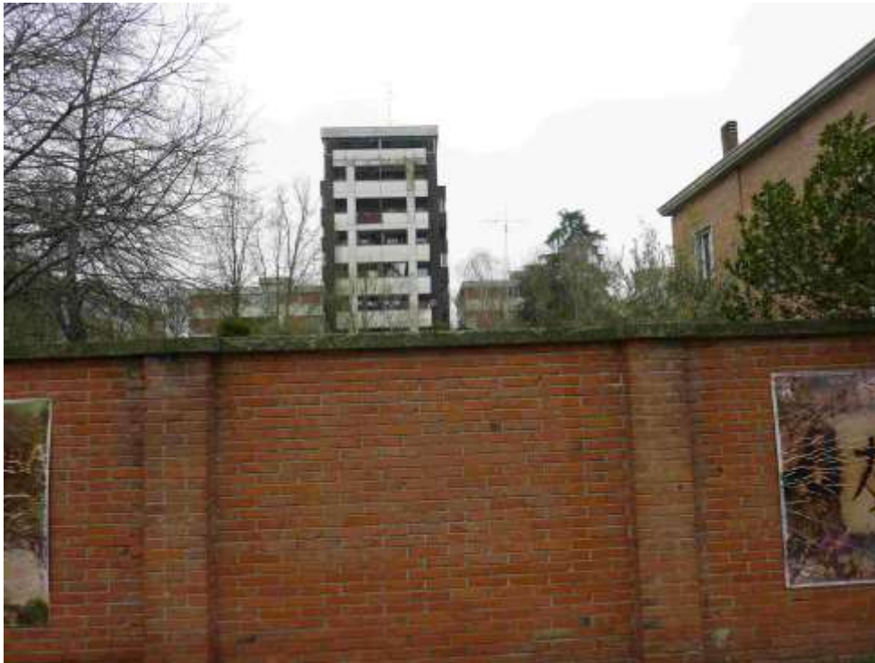
02 – Vista lato Sud da Via Paradisi
