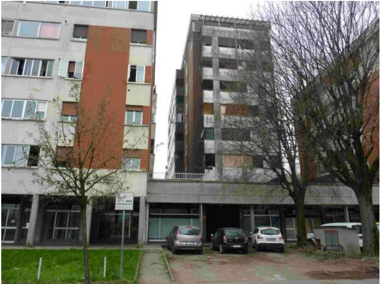
01 – Vista lato Nord da Via Giuseppe Turri Civico 37
