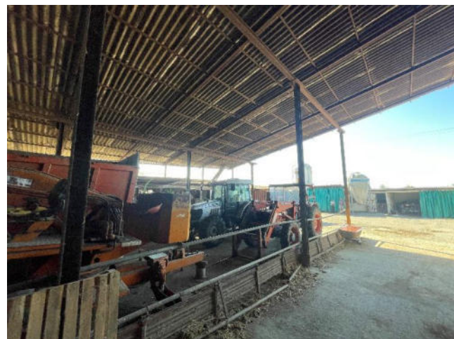
Vista interna magazzino
