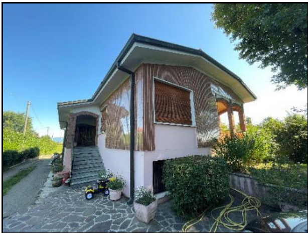
Vista facciata esterna
