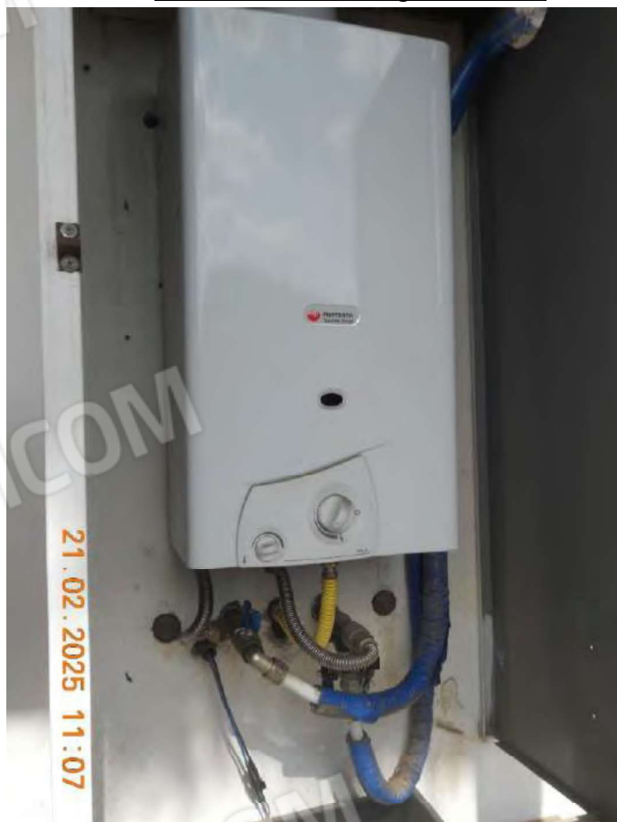
Foto n. 26 – Particolare caldaia a gas in disuso
