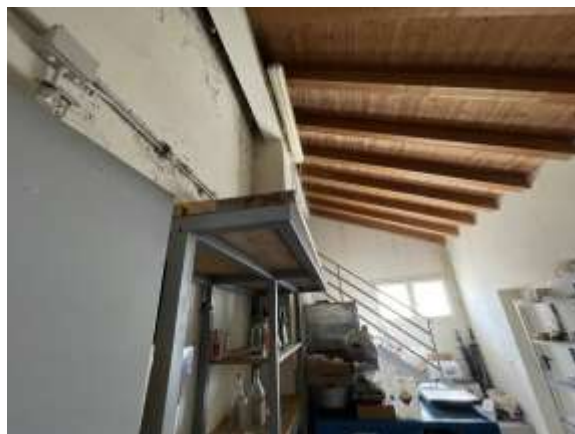
Interno 12 (magazzino e scala al sottotetto)
