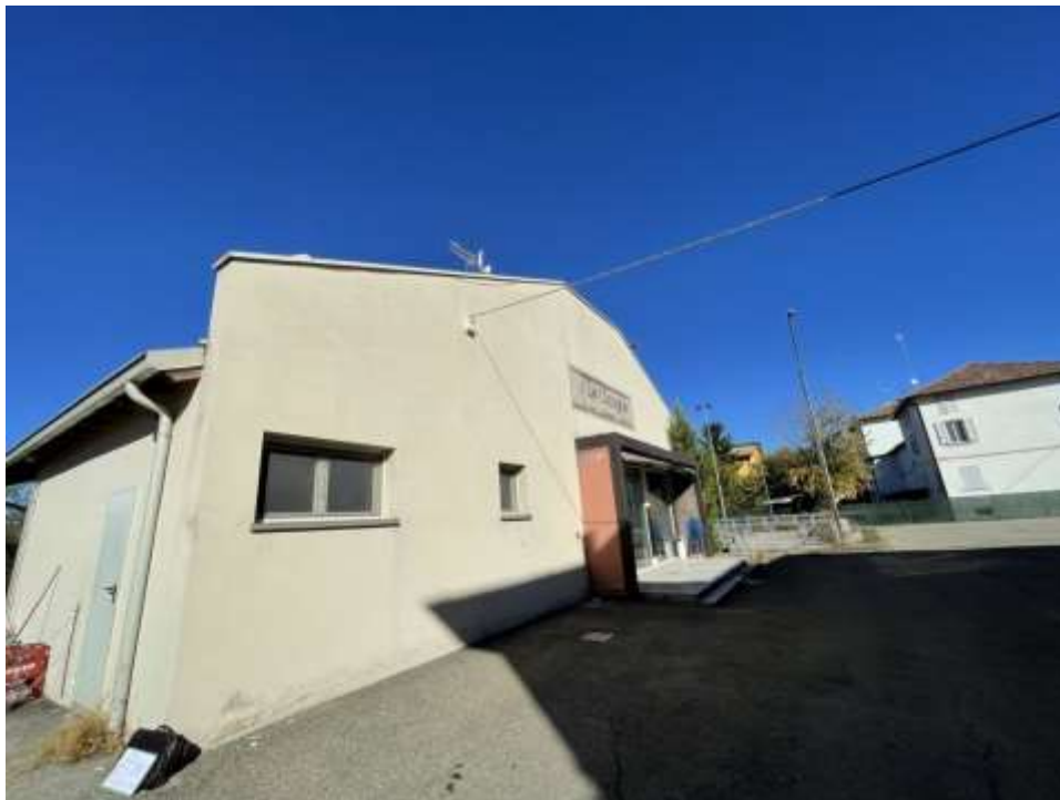
Esterno 1 (fronte principale Est)
