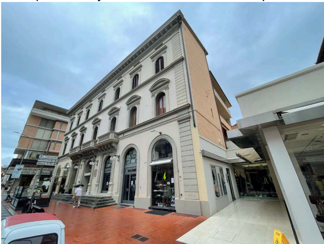
FOTO 1 (vista esterna frontale da corso Giacomo Matteotti)
