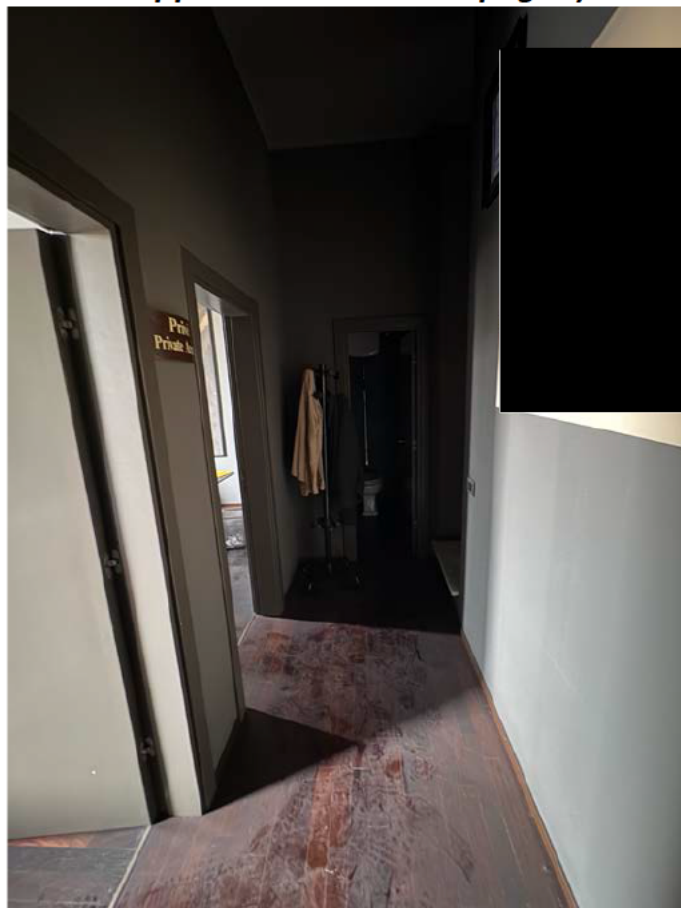
FOTO 11 (vista interna appartamento – disimpegno)
