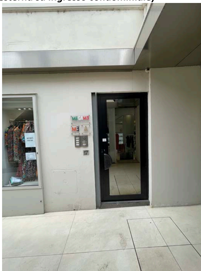
FOTO 2 (vista esterna su ingresso condominiale)
