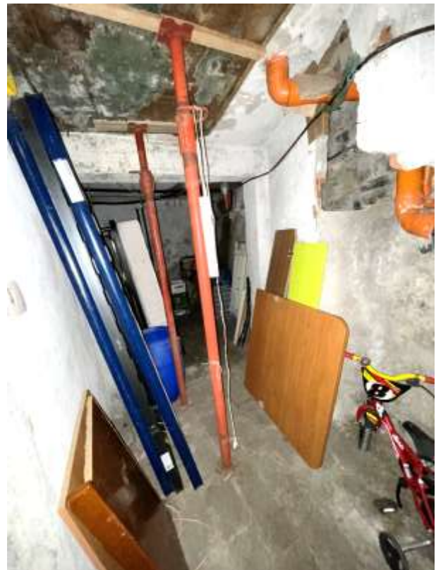
foto n. 15: LOCALI ACCESSORI APPARTAMENTO A PIANO PRIMO vista interna della cantina
