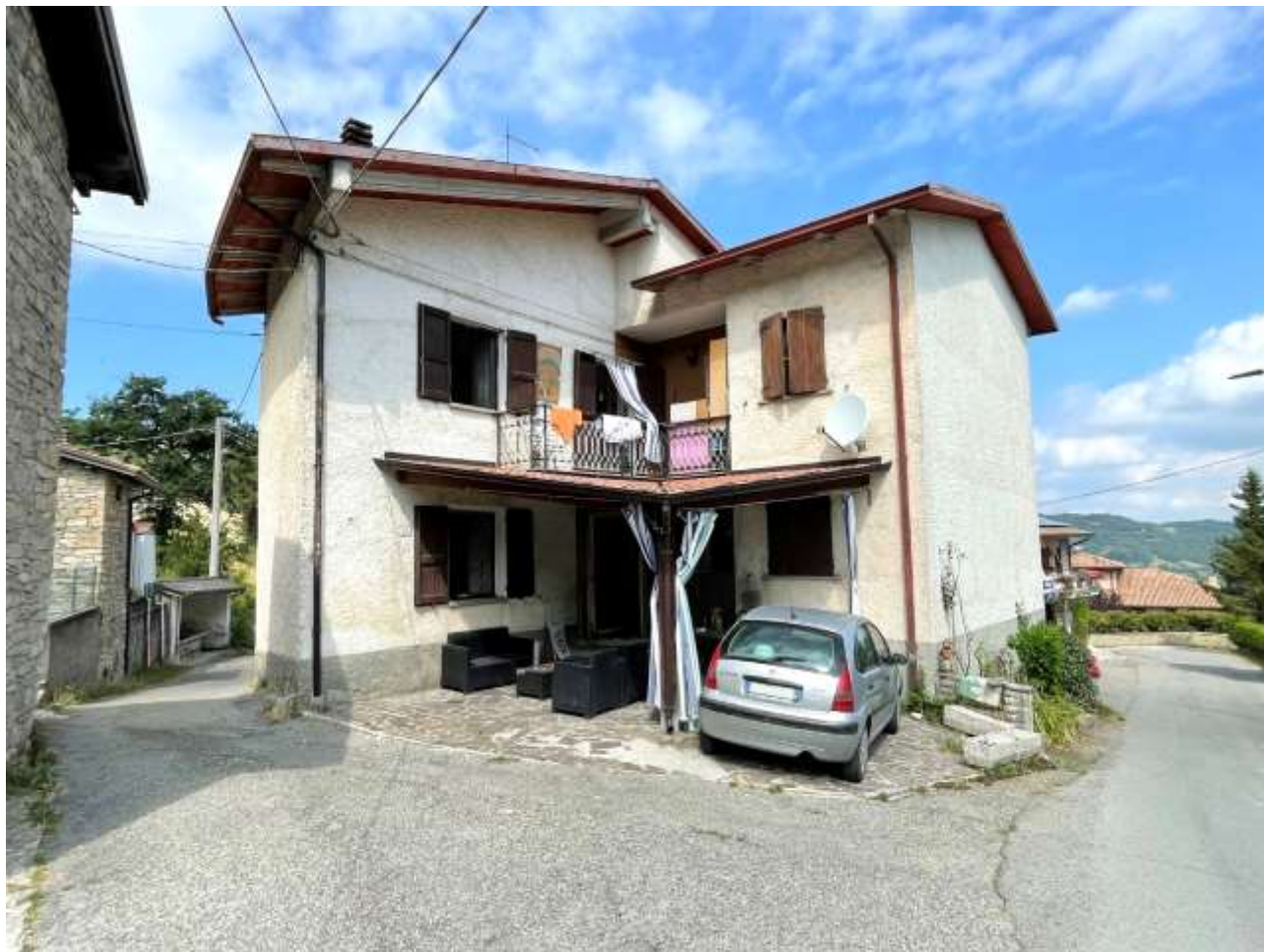
foto n. 1: vista lato sud del fabbricato oggetto di stima
