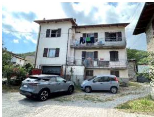
foto n. 3: vista lato nord del fabbricato oggetto di stima
