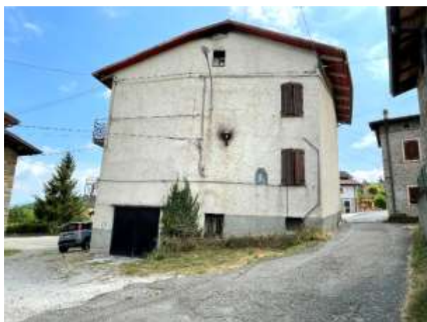
foto n. 2: vista lato ovest del fabbricato oggetto di stima
