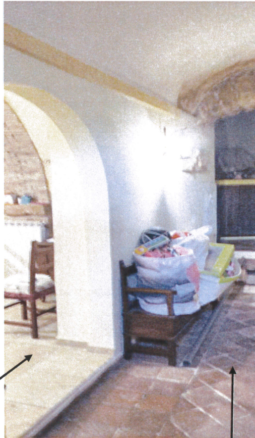
Vista varco di accesso all'unità immobiliare sub. 11
