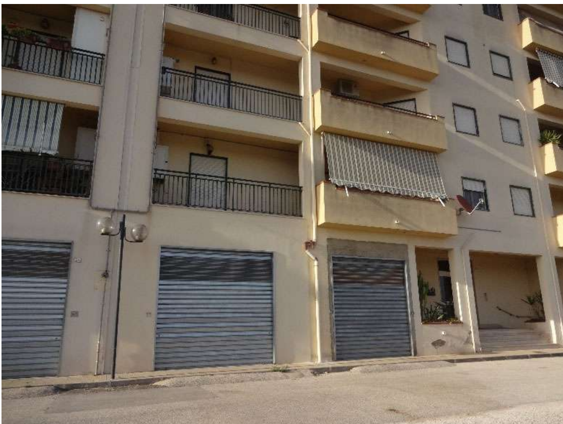
Foto 6 – Particolare del Prospetto Principale (sud)
