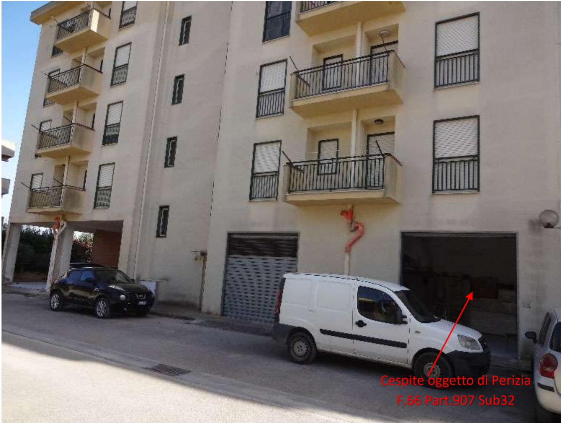
Foto 7 – Particolare del Prospetto Posteriore (nord)
