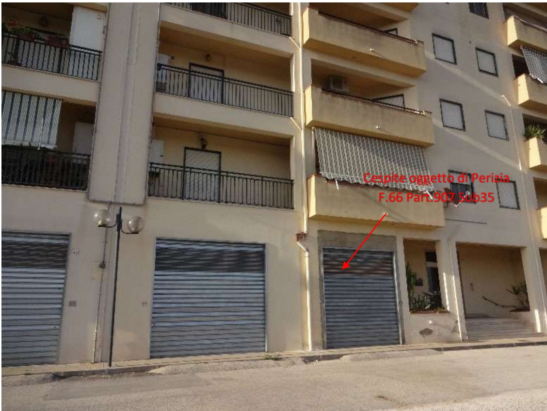
Foto 6 – Particolare del Prospetto Principale (sud)
