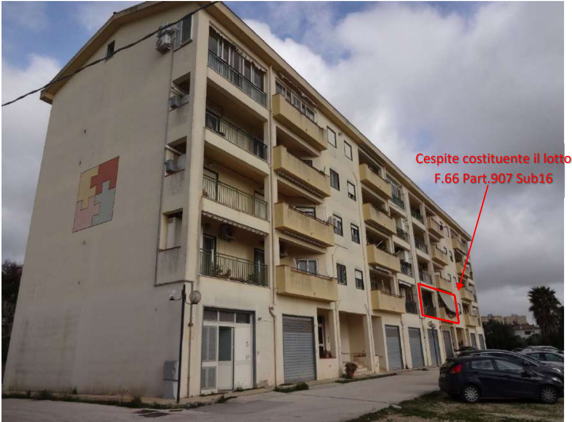
Foto 3-Prospetto principale su via Nilde Iotti
