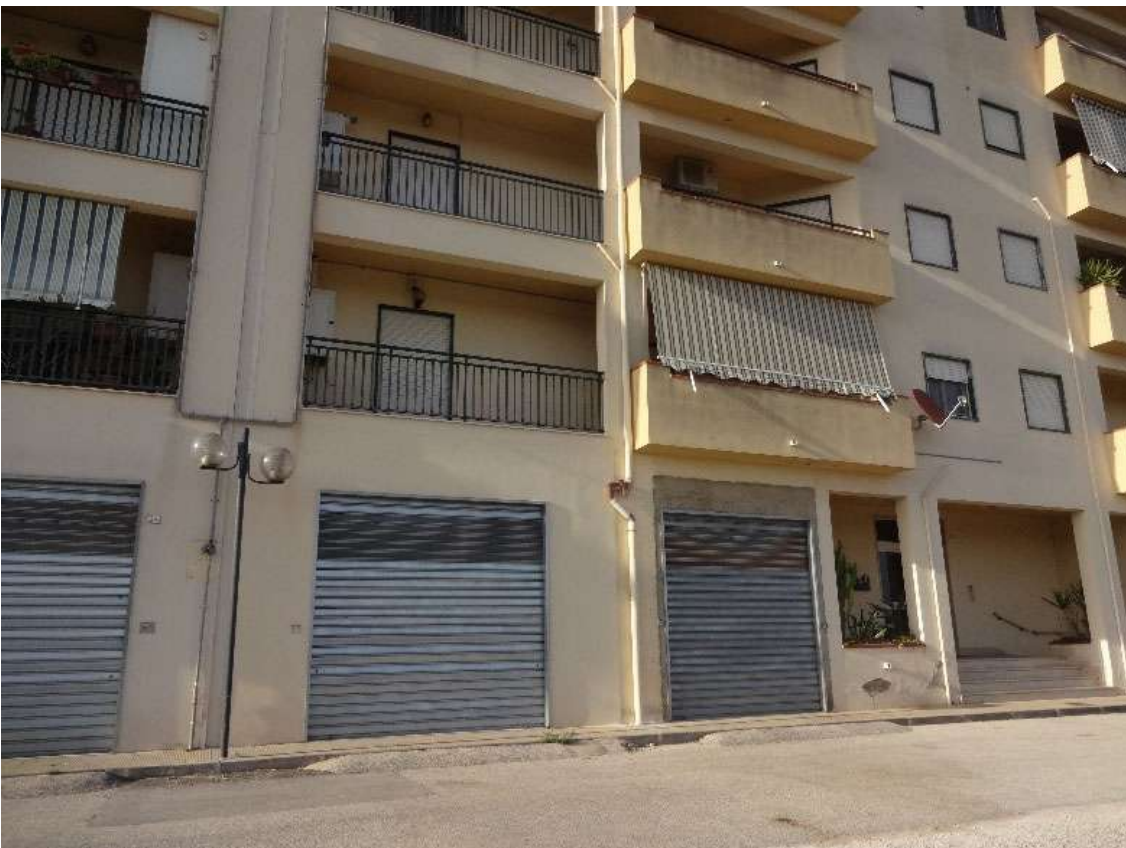
Foto 6 – Particolare del Prospetto Principale (sud)
