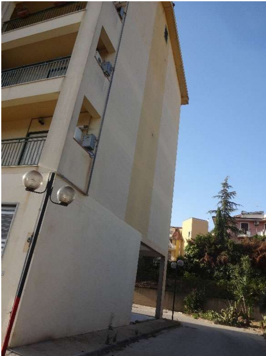
Foto 5 – Prospetto Laterale (est)
