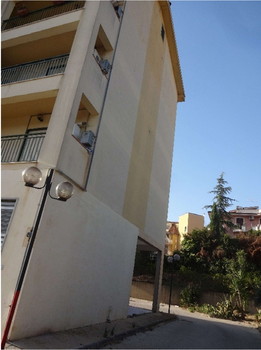
Foto 5 – Prospetto Laterale (est)
