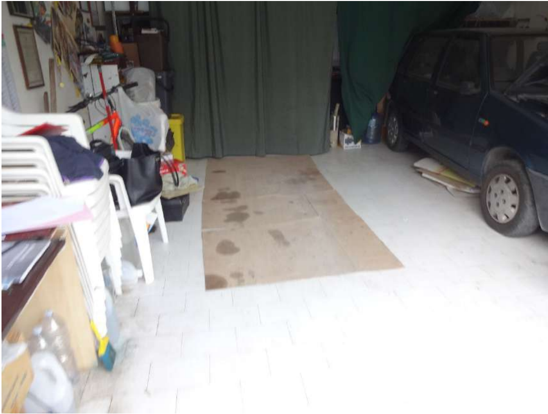
Foto 9 – Particolare degli interni (F.66 Part.907 Sub 33)
