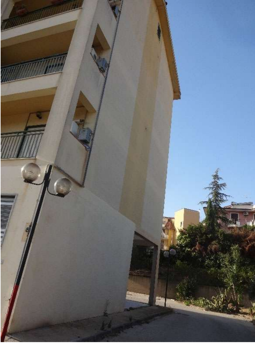
Foto 5 – Prospetto Laterale (est)
