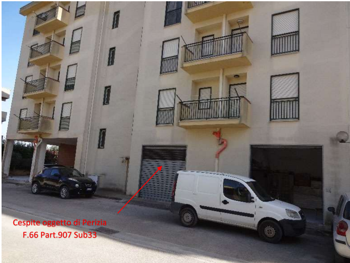
Foto 7 – Particolare del Prospetto Posteriore (nord)
