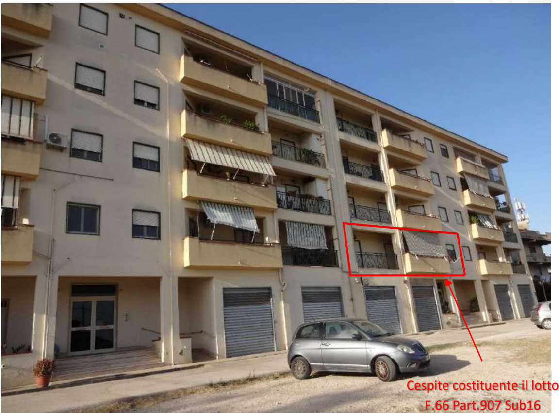
Foto 4-Prospetto principale su via Nilde Iotti
