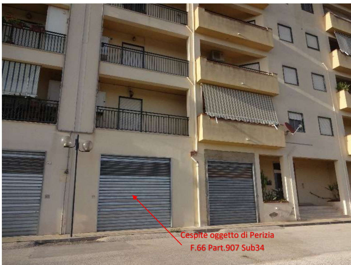
Foto 6 – Particolare del Prospetto Principale (sud)
