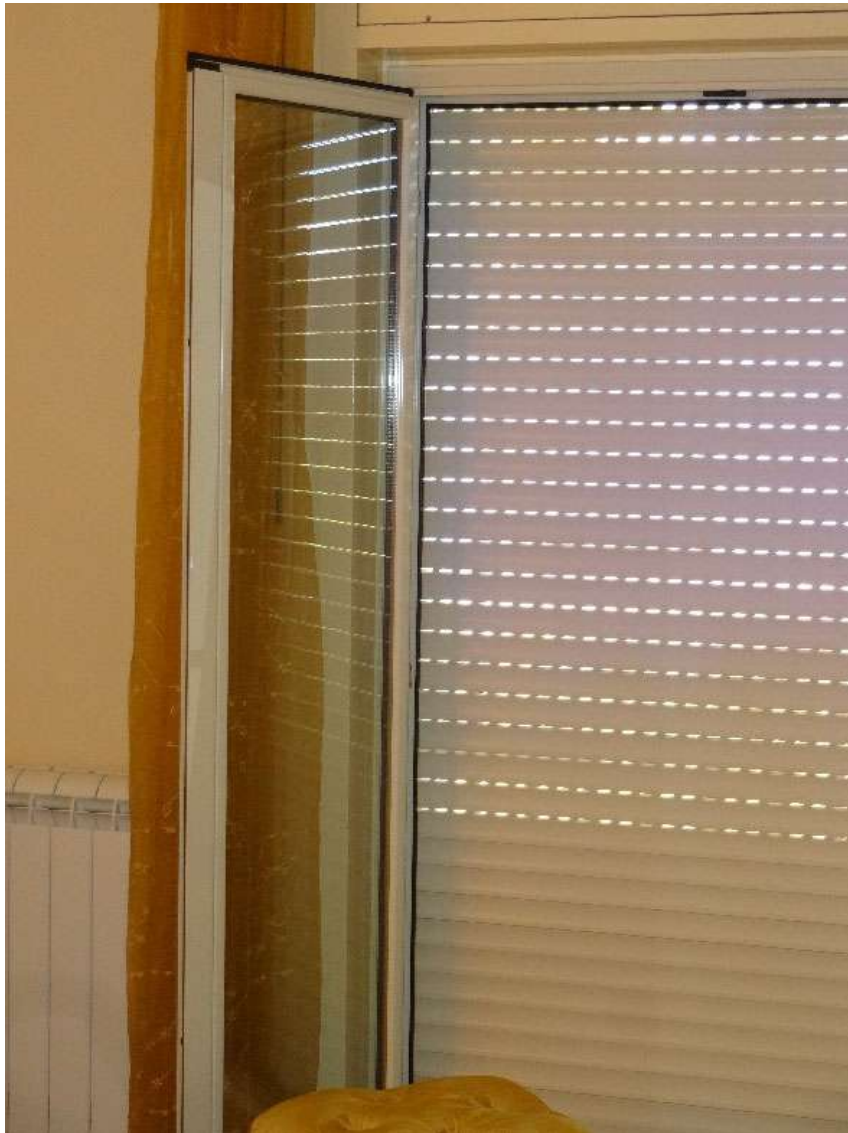
Foto 28-Interni del vano n.2
