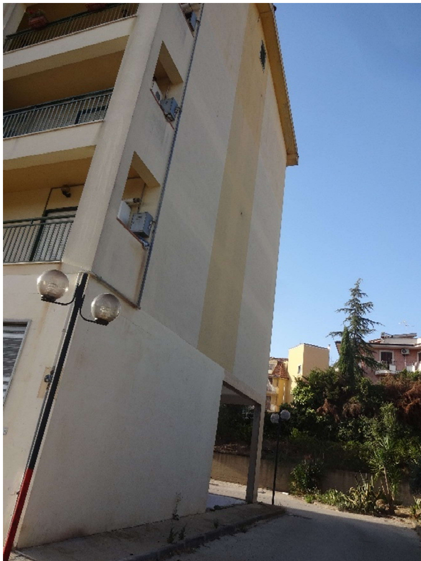
Foto 5 – Prospetto Laterale (est)
