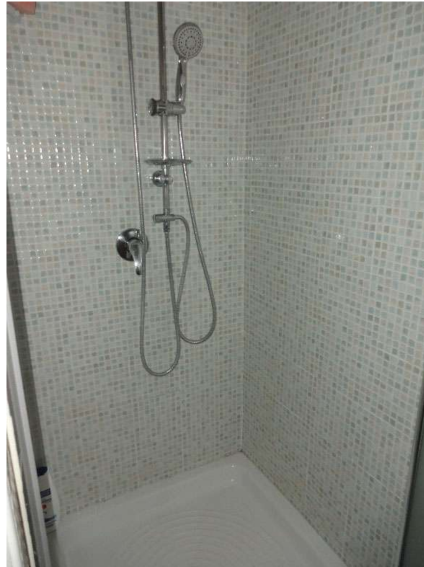
Foto 22-Interni del WC n.2
