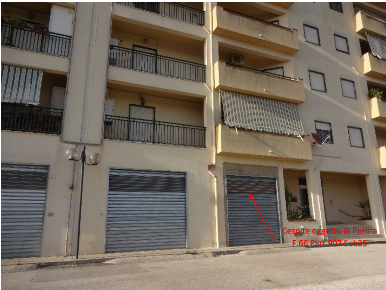
Foto 4-Accesso al cespite (via Nilde Iotti)
