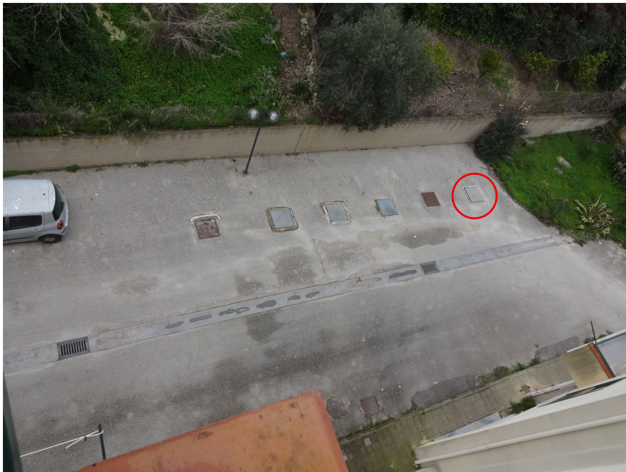
Foto 6-Vasche idriche in corrispondenza del prospetto posteriore (quella cerchiata in rosso è a servizio dell'appartamento costituente il lotto e di un altro appartamento di proprietà di soggetti terzi)
