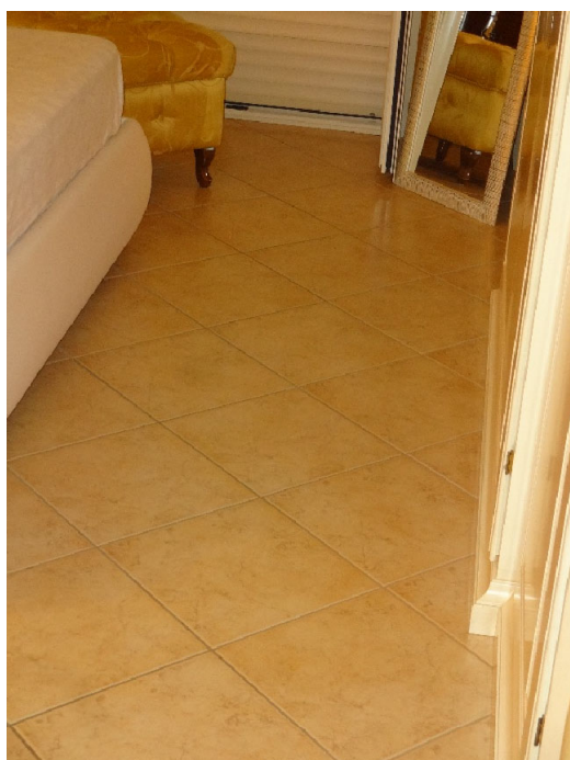
Foto 25-Interni del vano n.2
