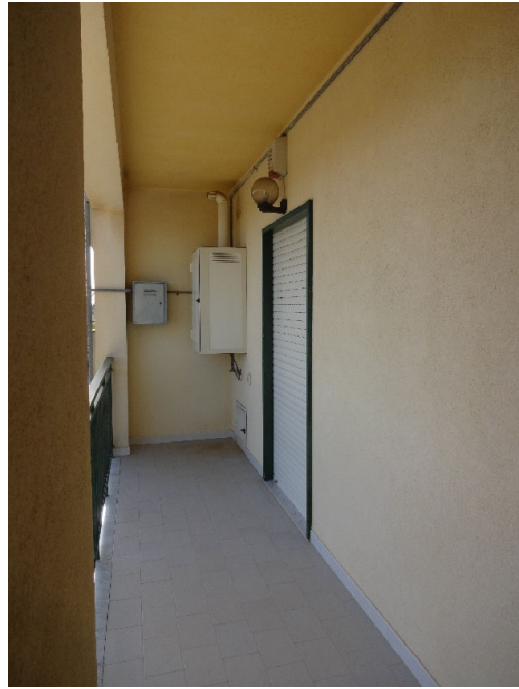
Foto 36-Veranda in corrispondenza del prospetto principale
