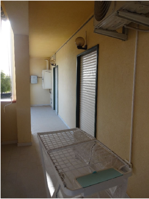
Foto 35-Veranda in corrispondenza del prospetto principale
