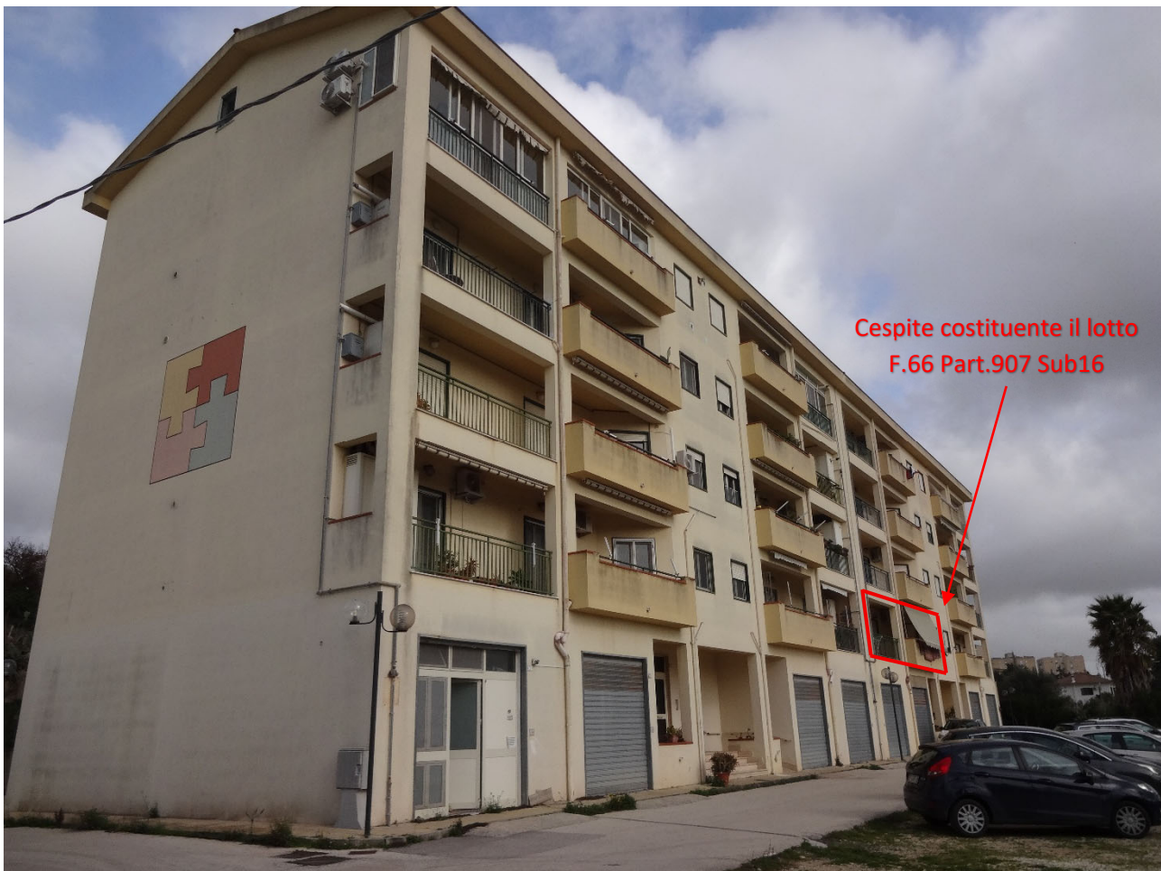
Foto 2-Prospetto principale su via Nilde Iotti (03.01.2026)
