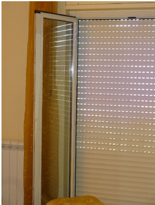
Foto 27-Interni del vano n.2
