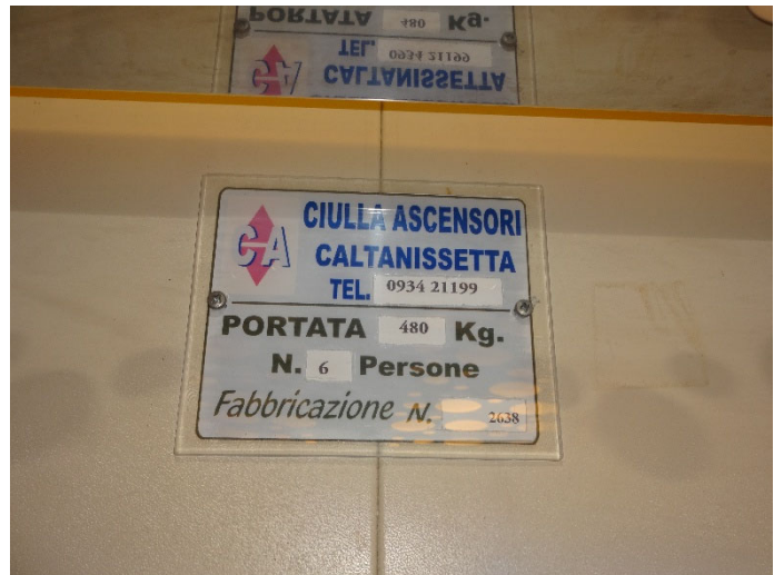
Foto 14-Caratteristiche dell'ascensore
