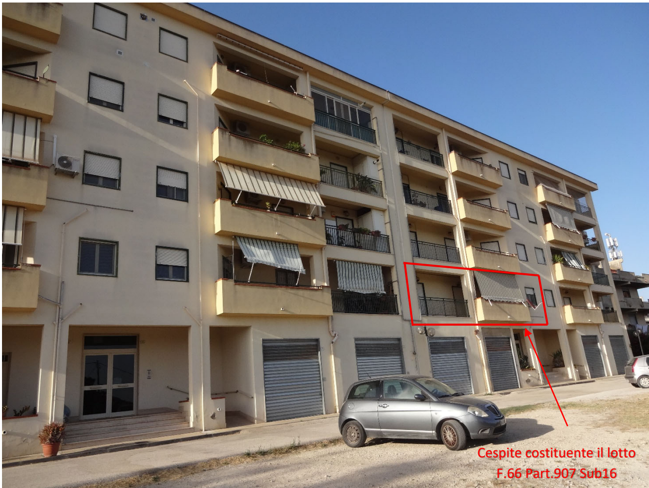
Foto 3-Prospetto principale su via Nilde Iotti (24.07.2025)
