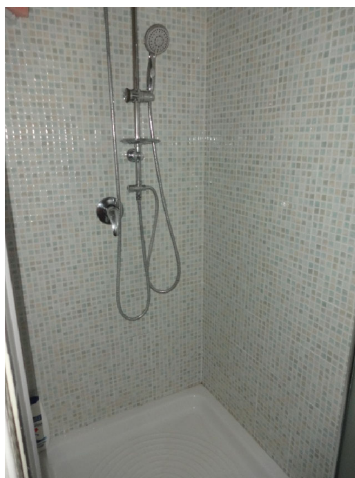
Foto 22-Interni del WC n.1
