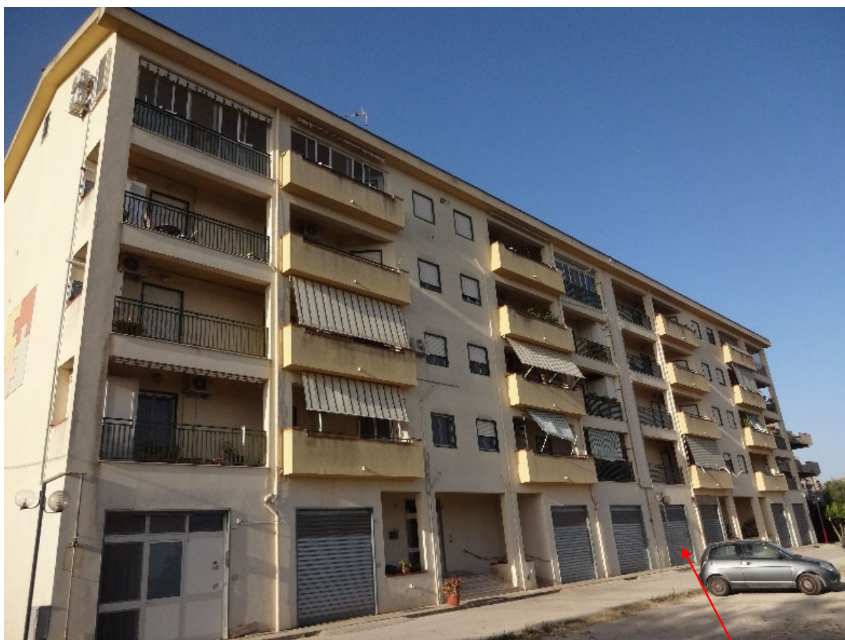
Foto 2-Prospetto Principale (via Nilde Iotti)
