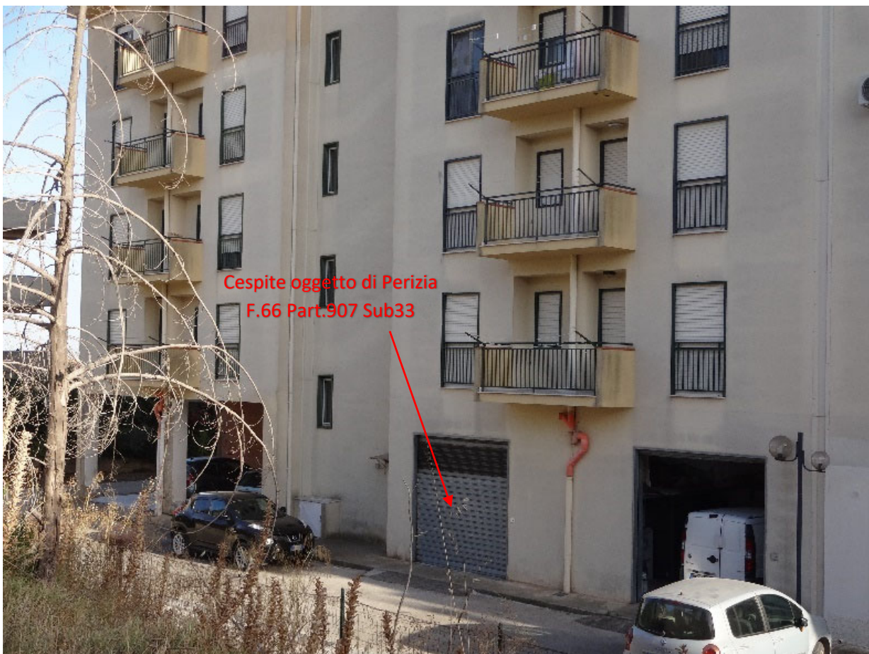
Foto 4-Cespite oggetto di perizia (prospetto posteriore del fabbricato)
