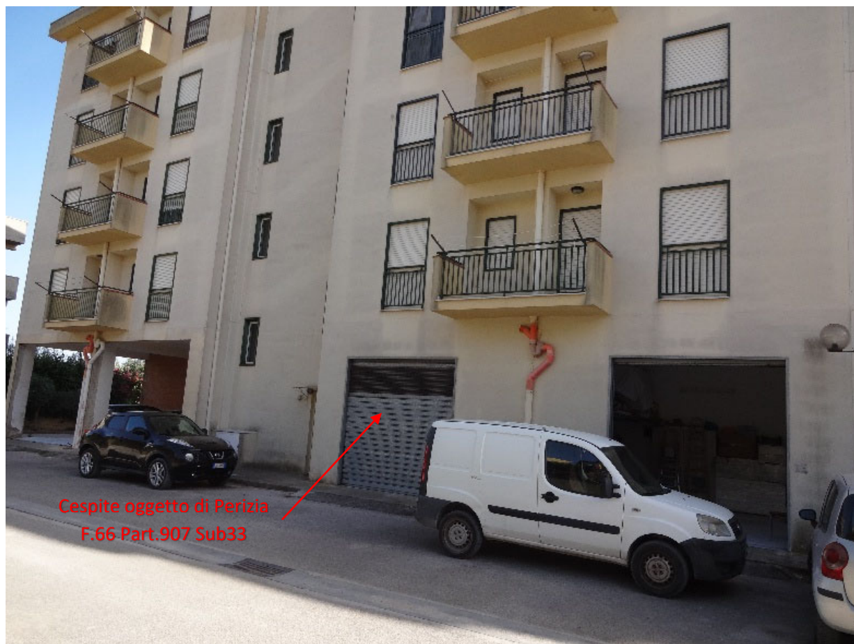
Foto 5-Cespite oggetto di perizia (prospetto posteriore del fabbricato)
