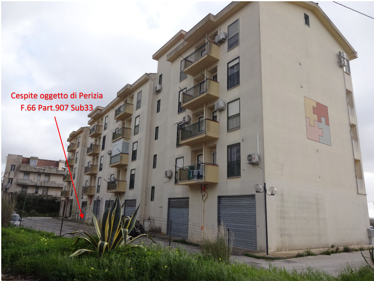
Foto 3-Cespite oggetto di perizia (prospetto posteriore del fabbricato)
