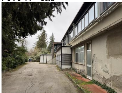
FOTO 14 - Prospetto a valle
