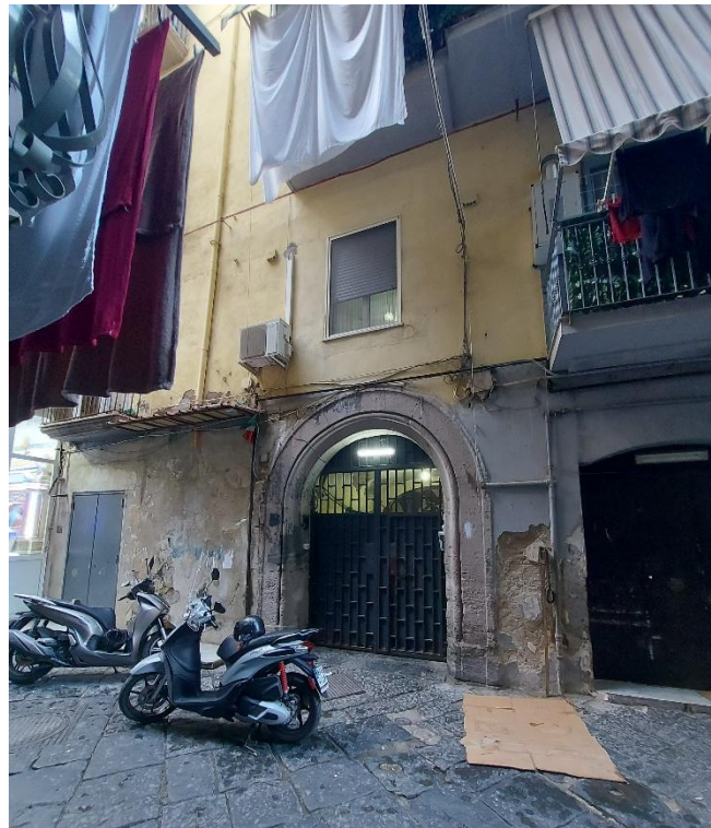
via San G. Calasanzio - Portone accesso fabbricato bene 2 civ.5
