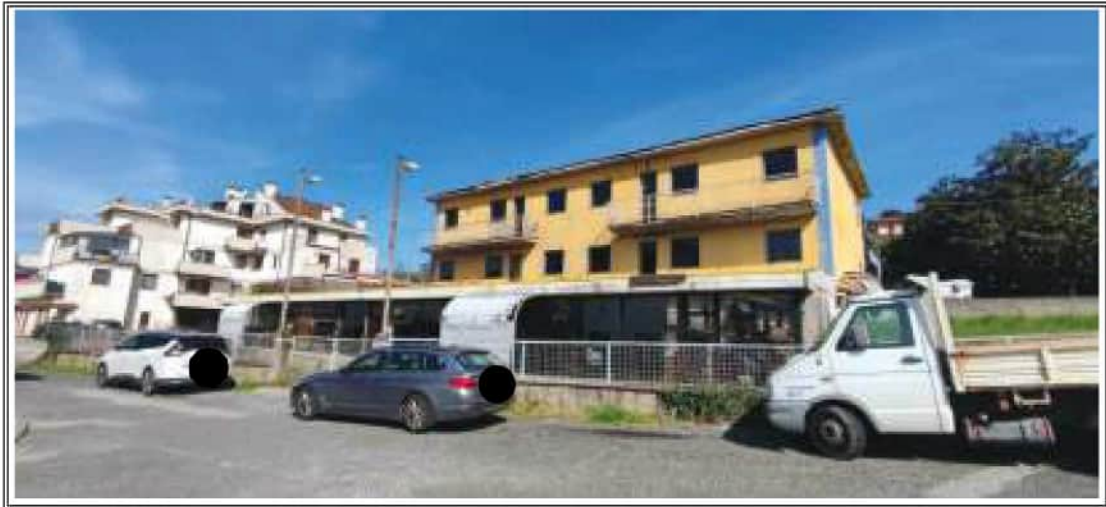
Foto n. 1 – Vista del codominio da Via Germania
