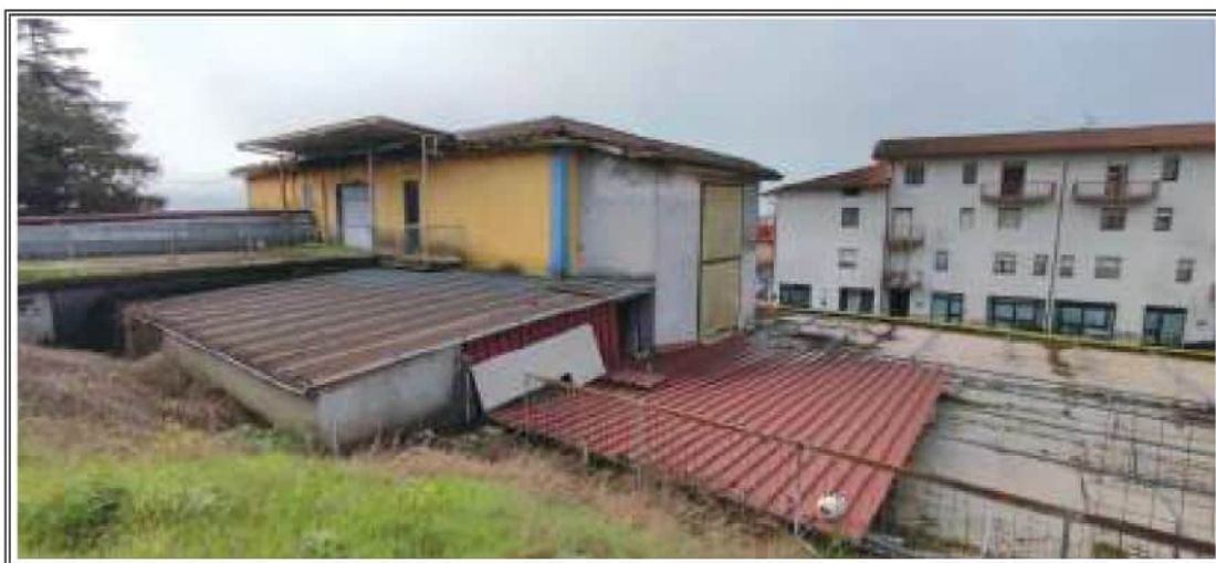
Foto n. 4 – Vista del codominio da Via Francia
