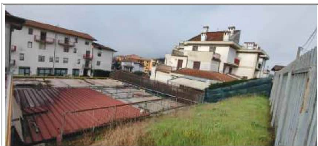
Foto n. 5 – Vista del codominio da Via Francia
