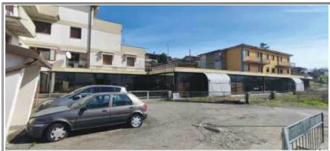
Foto n. 6 – Vista del codominio da Via Germania
