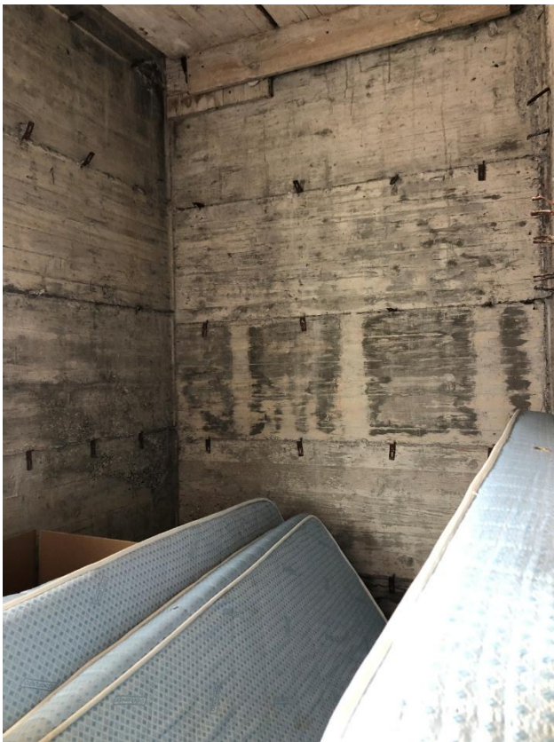
Vano ascensore in cemento armato
