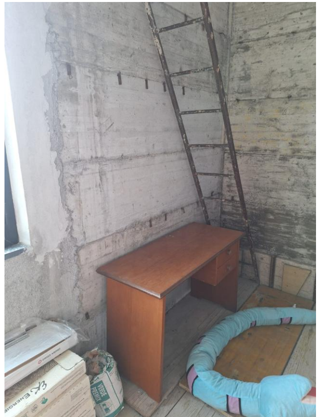
Vano ascensore in cemento armato
