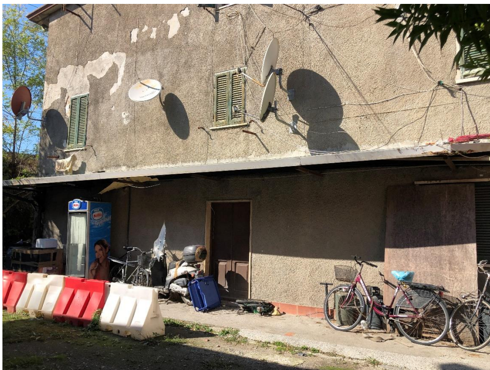
Foto 7/8 – Piano Terra Prospetto lato Massa
