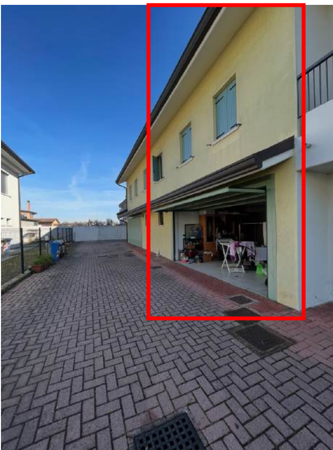
6 - vista del fronte ovest corsia comune
