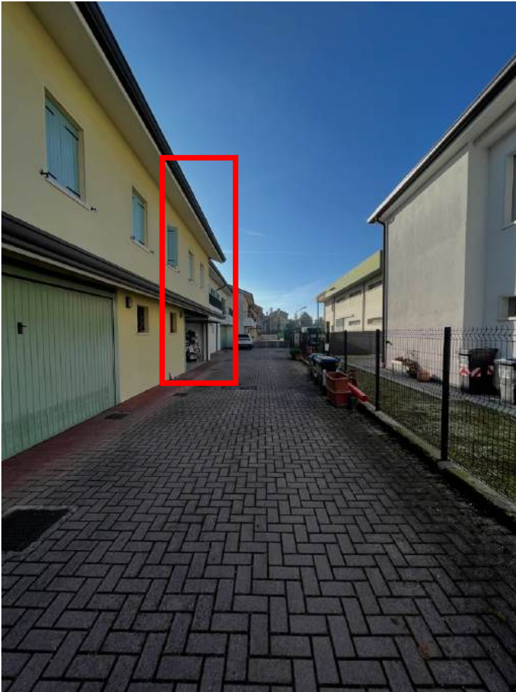
7 - vista del fronte ovest corsia comune e fronteggiamento con altra unità a meno di 10 m
