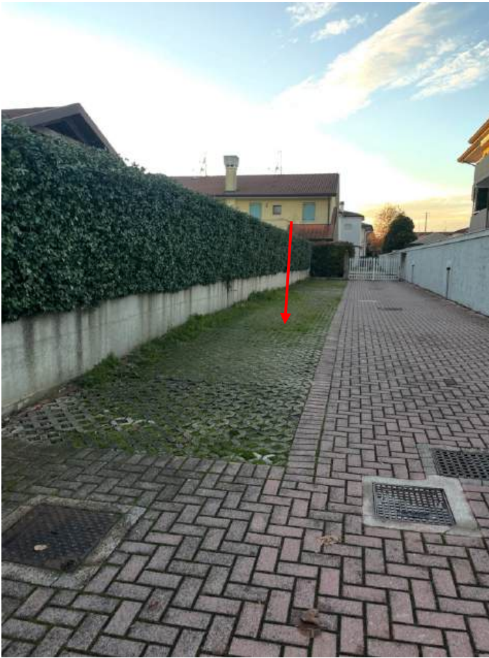
1 - vista corsia di accesso comune (sub.2) da via Manzoni e posto auto pignorato (sub.11)
